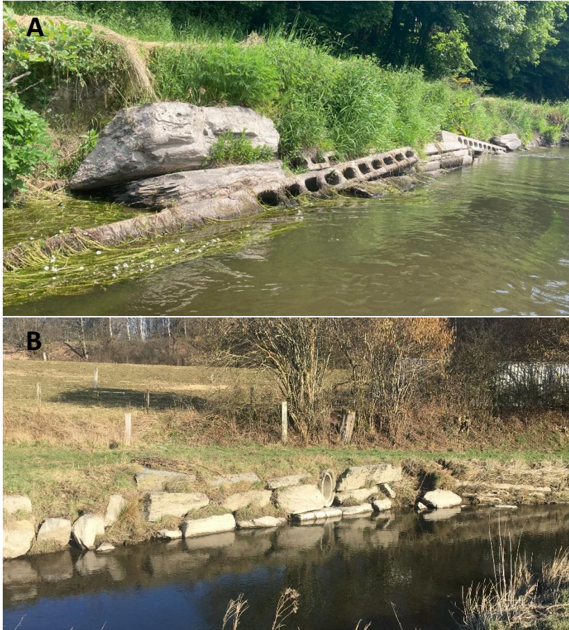
Figure 25 : Photo des enrochements de berges de la rive gauche du site aval sur la Vierre. A : aval du site. B : amont du site. Auteurs : Q. Vaessen et L. Pacyna.
