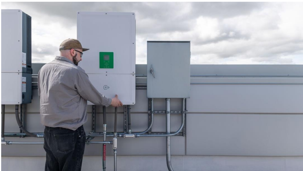
FIGURE 17 : INSTALLATEUR DE BATTERIES
