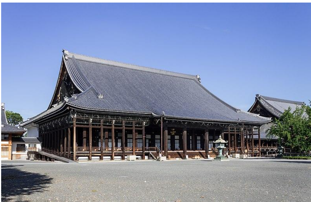
Figure 31 Photographie du temple Nishi Hongan-ji - source : Kakidai, CC BY-SA 4.0 via Wikimedia Commons
