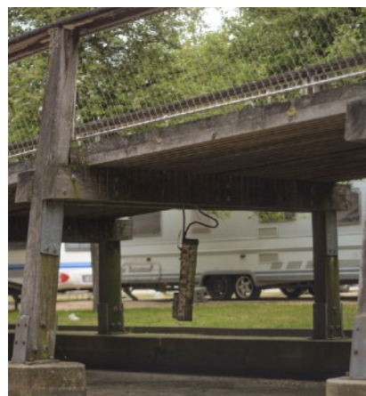
Figures 113-114 : photos du Mirador
