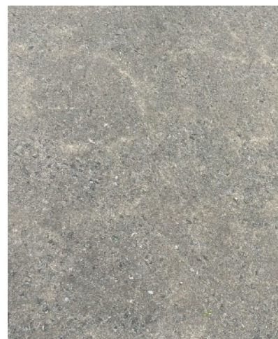
Figure 96 : béton des Douves
