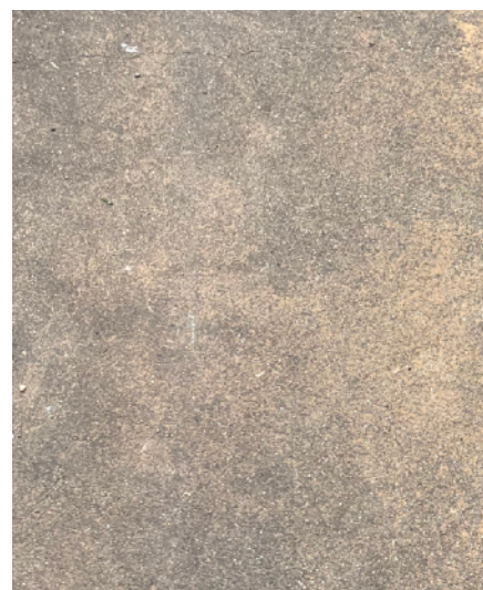
Figure 86 : Dalle en béton de la Fosse
