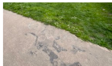
Figures 90 - 92 : différents revêtements du sol de la Cantine
