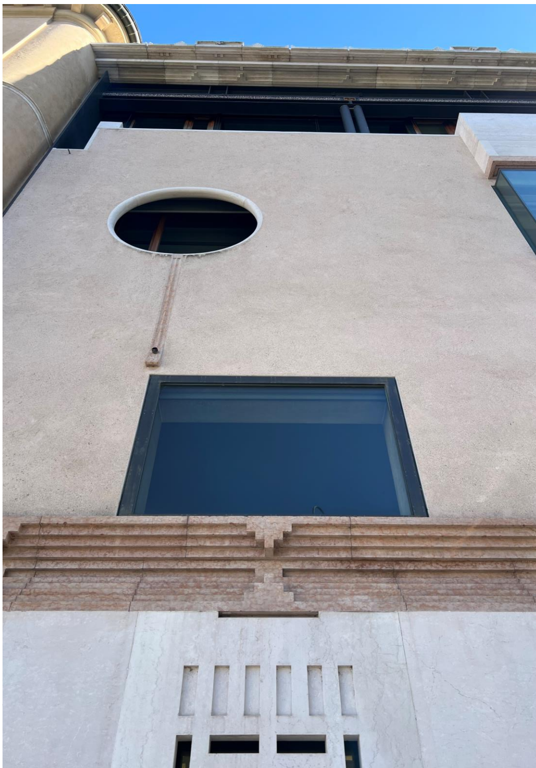
fig. 68 : Façade à rue de la Banque Populaire de Vérone.
