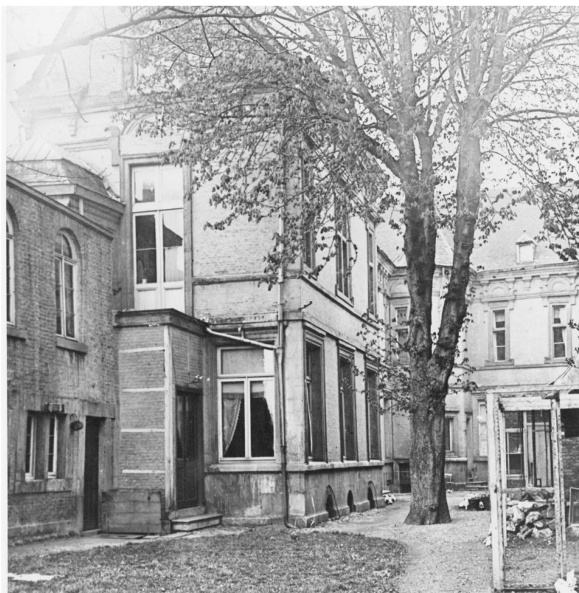
fig. 3 : Vue extérieure de la cour intérieure au début du XX e siècle.
