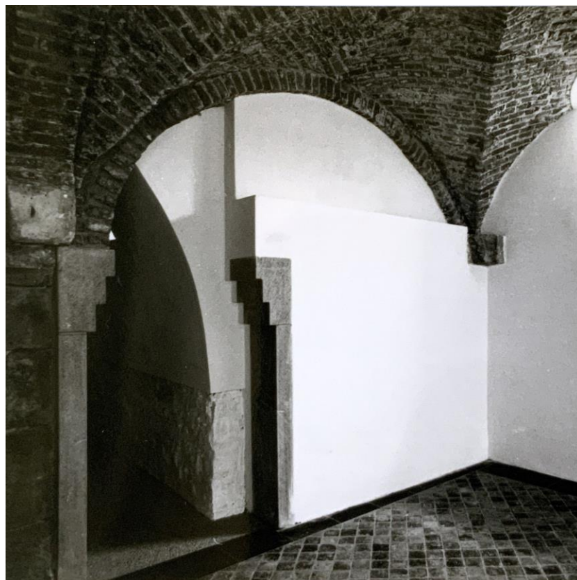
fig. 79 : Consoles des voûtes de la crypte de l'Hôtel Torrentius, 1981.
