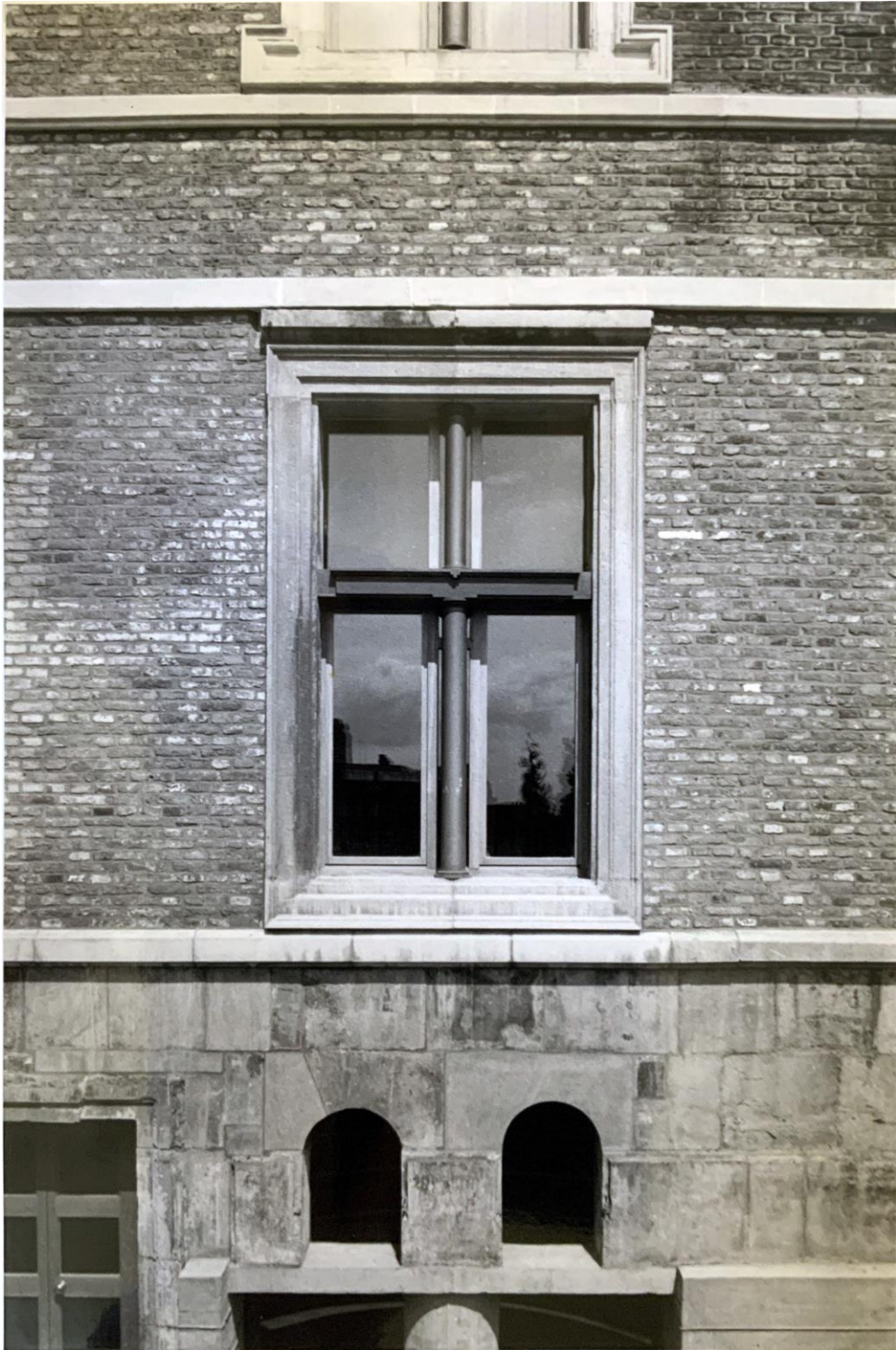
fig. 64 : Croisées de la fenêtre du pignon sud de l'Hôtel Torrentius, 1981. La traverse présente un motif de ziggourat en son centre.
