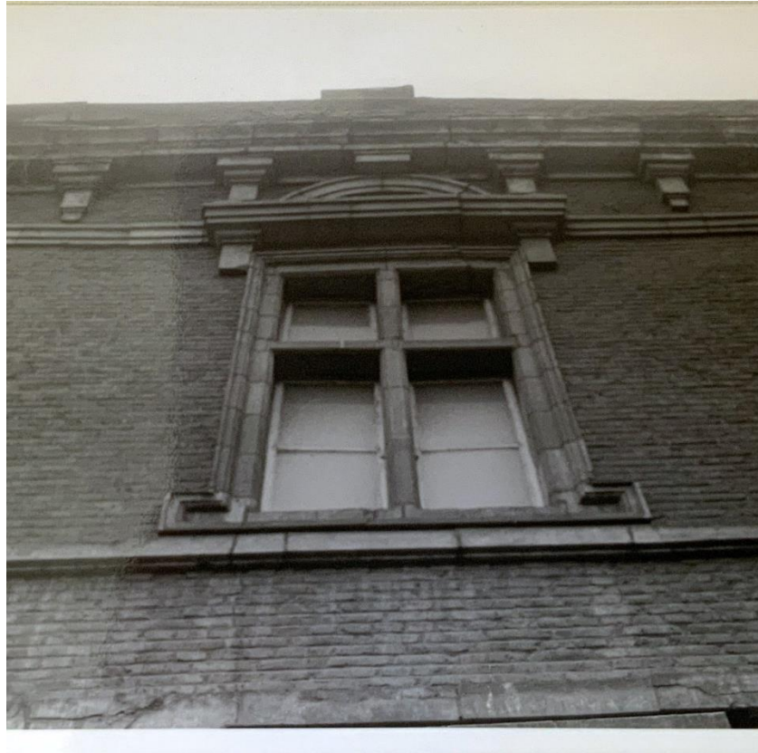
fig. 19 : Vue extérieure des croisées de fenêtres type en 1977.
