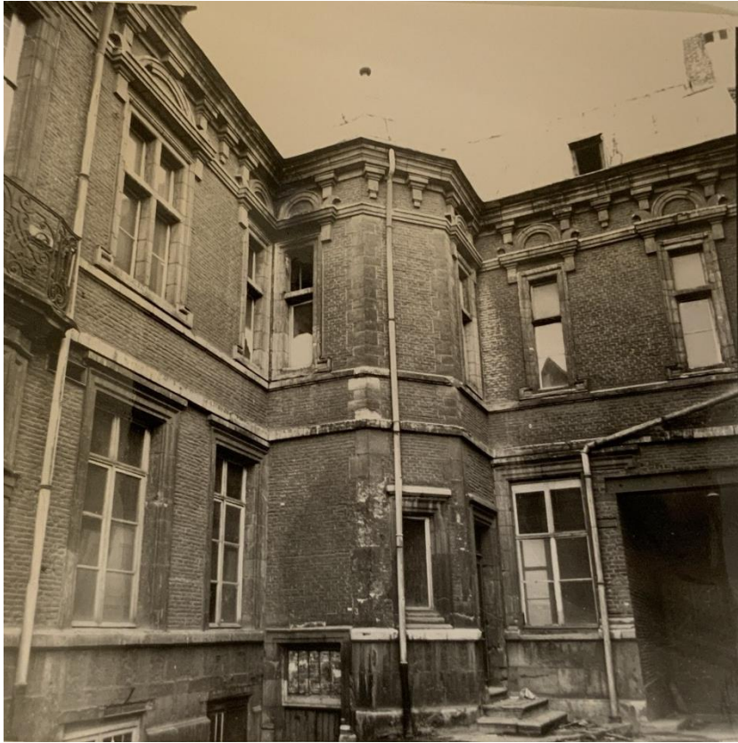
fig. 13 : Vue extérieure de l'angle est-sud et de la tourelle en 1977.
