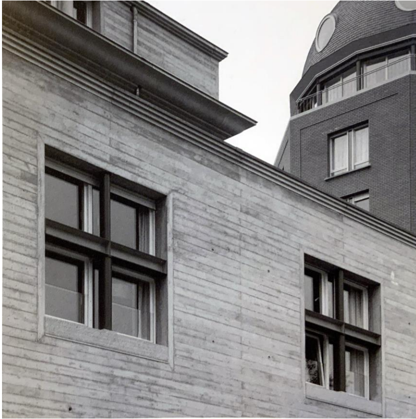
fig. 72 : Traverse de la croisée au Balloir, prenant la forme d'une corniche, de la même façon que pour la façade de la Banque Populaire de Vérone.
