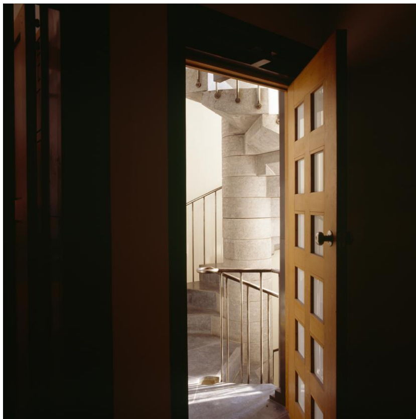
fig. 113 : Vue de l'escalier de la tourelle depuis le hall du premier étage de l'Hôtel Torrentius, en 1981.
