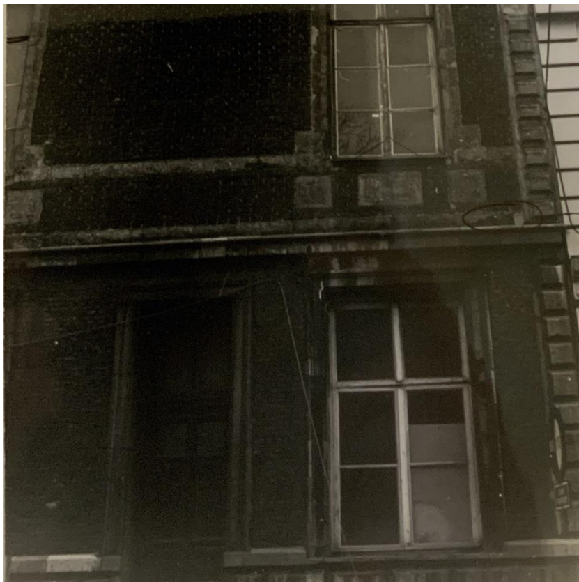
fig. 6 : Vue extérieure de la porte d'entrée à rue en 1977.
