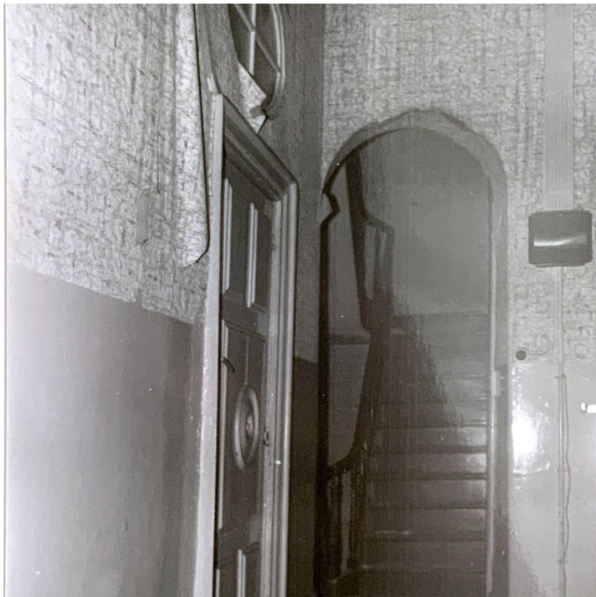
fig. 36 : Escalier côté rue en 1977.
