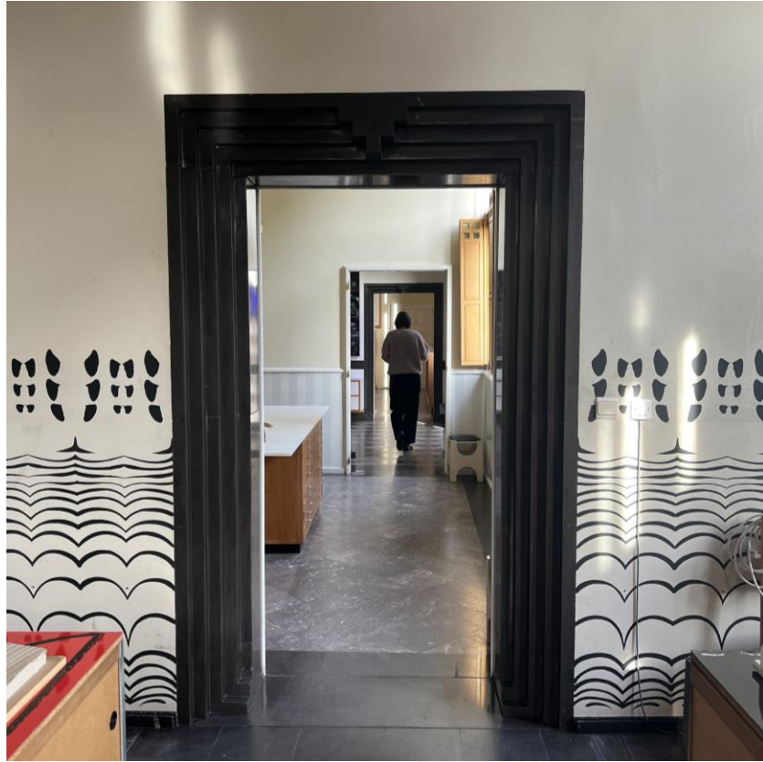
fig. 76 : Encadrement type d'une porte intérieure de l'Hôtel Torrentius.
