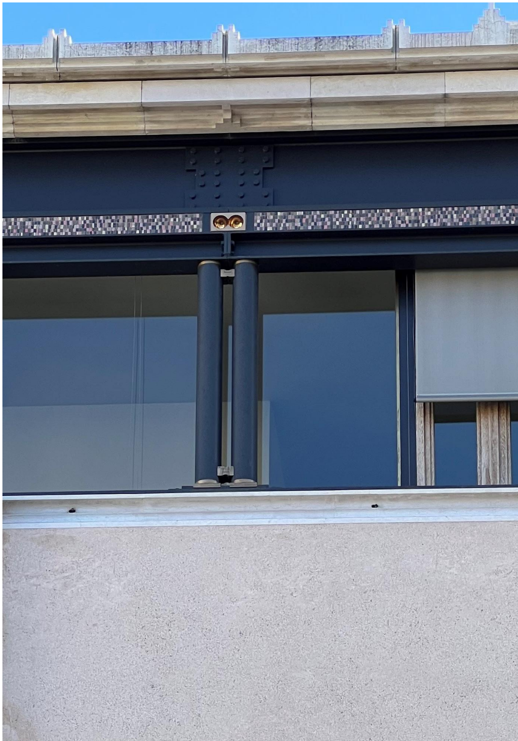
fig. 69 : Poutre maîtresse prenant la forme d'une corniche à la Banque Populaire de Vérone.
