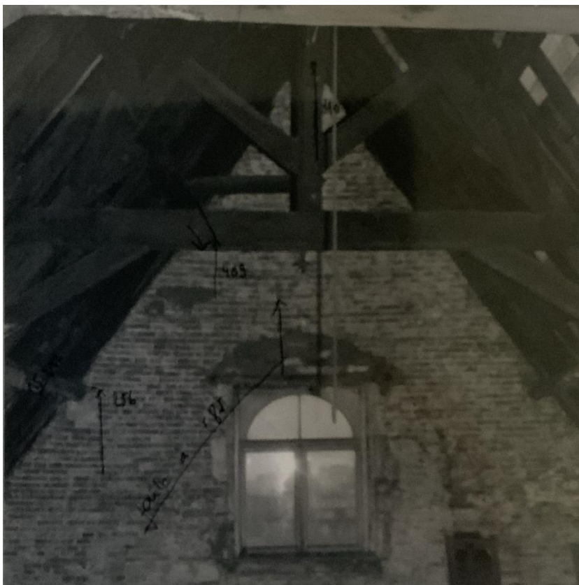
fig. 30 : Charpente (et ses dimensions) en 1977.
