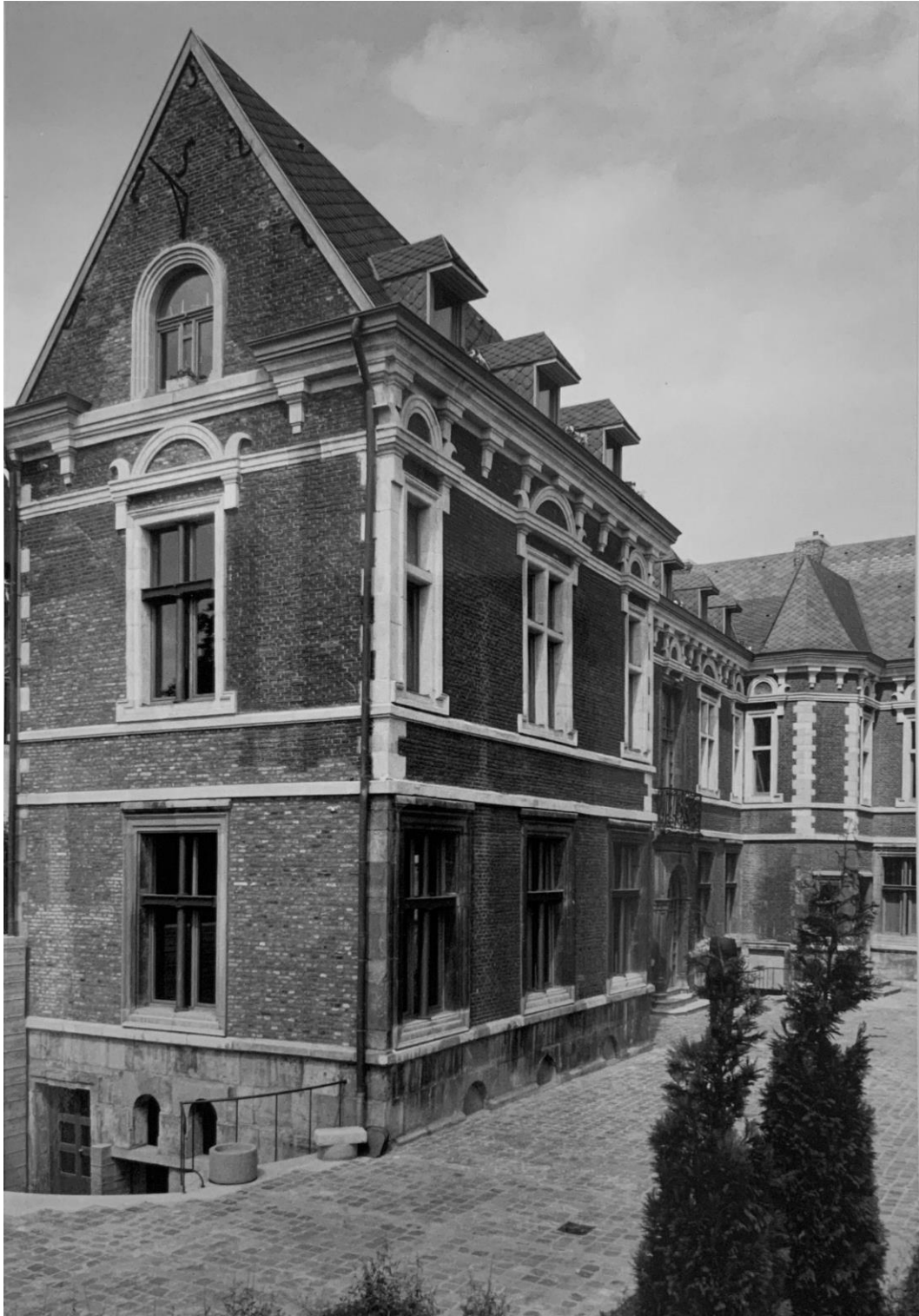
fig. 98 : Vue extérieure de la cour de l'Hôtel Torrentius en 1981.
