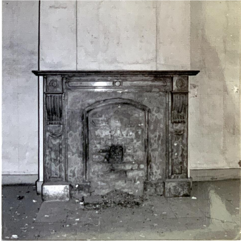
fig. 31 : Cheminée intérieure en 1977.
