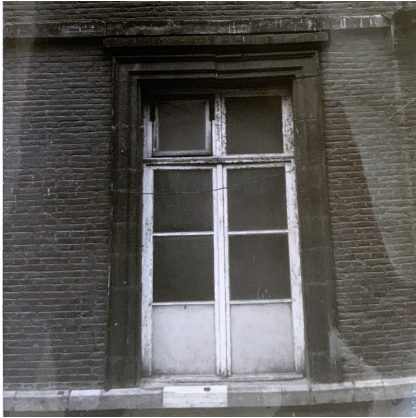
fig. 17 : Châssis type sans croisée en 1977.
