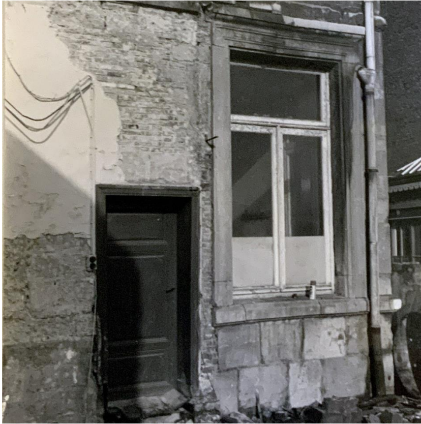
fig. 21 : Porte d'entrée de la cave depuis la façade sud en 1977.
