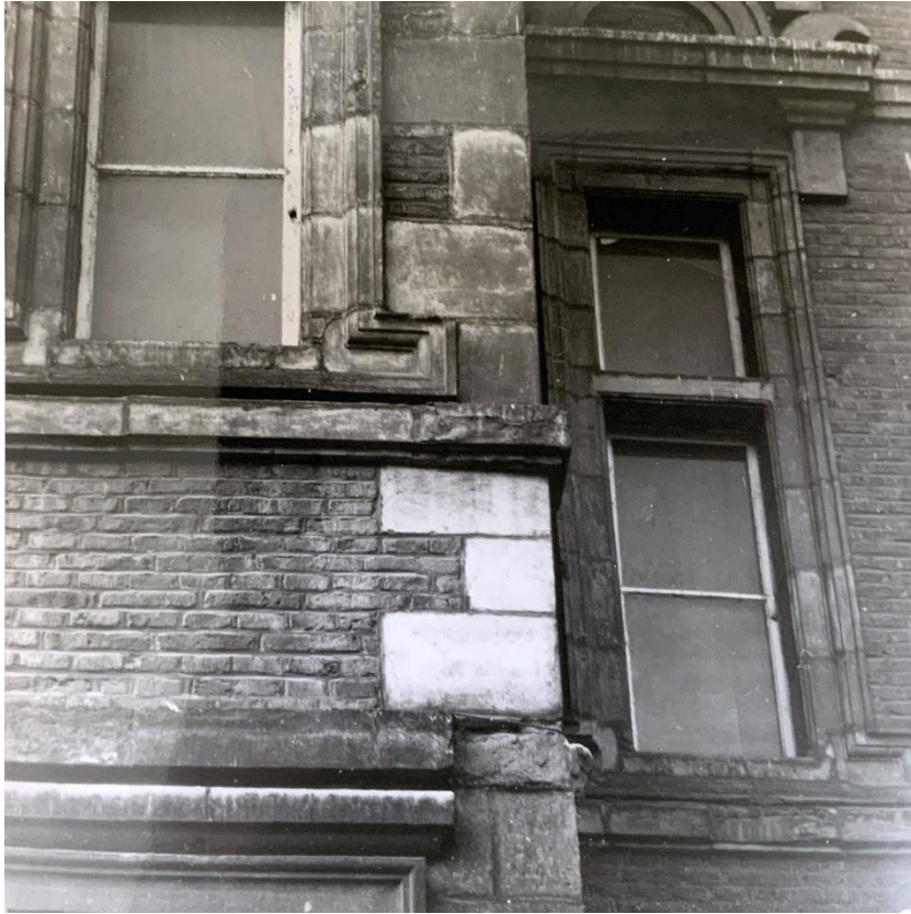
fig. 25 : Détail des briques de façade en 1977.
