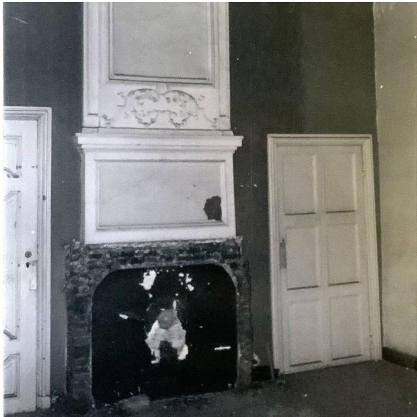
fig. 32 : Cheminée intérieure de l'aile droite en 1977.
