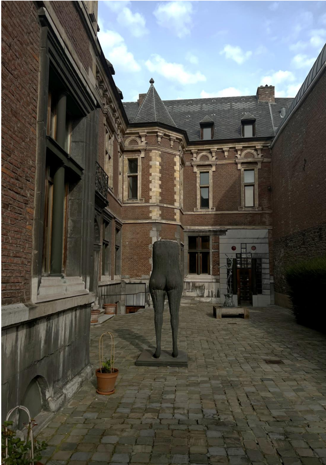
fig.44 : Façade sud et cour intérieure de l'Hôtel Torrentius en 2023.
