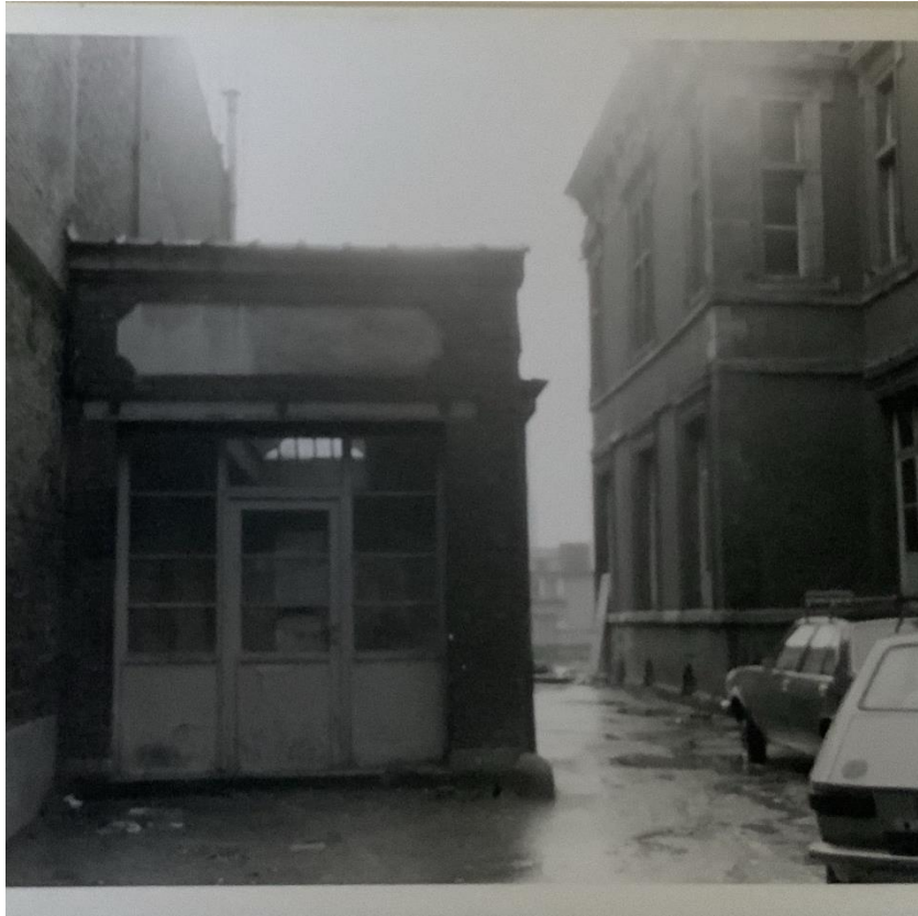
fig. 11 : Garage de la cour intérieure, vu depuis le porche d'entrée en 1977.
