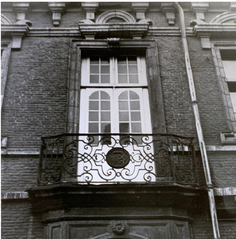
fig.10 : Vue extérieure du balcon de la façade est en 1977.
