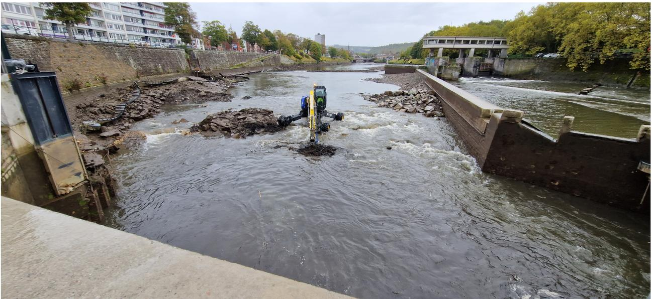
Figure 5: Photo n°5 du site des Grosses-Battes durant une mission de dragage
