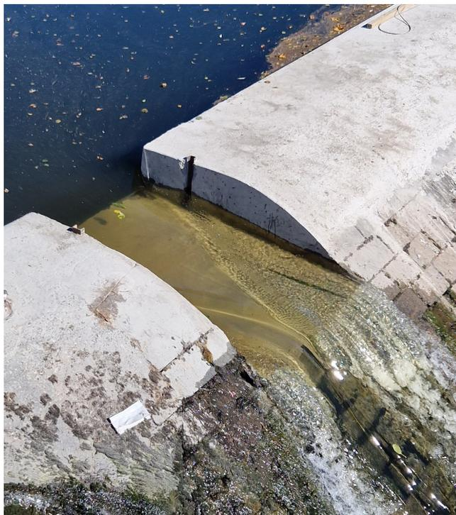
Figure 4.16: Incision sur le déversoir des Grosses-Battes
