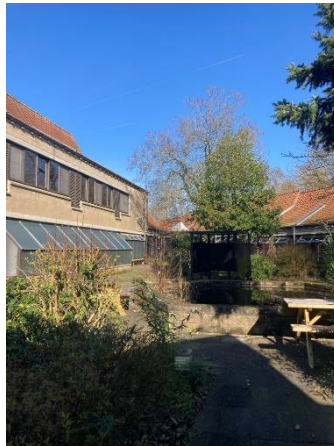
Figure 25 : Photographie d'un des espaces extérieurs de la maison de détention de Courtrai (Source : images prises lors de la visite, 2024)
