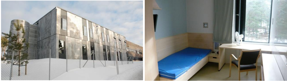
Figure 2 et 3 : Façades de la prison de Halden et intérieur d'une cellule (Source : Leroy, J. 2015)
