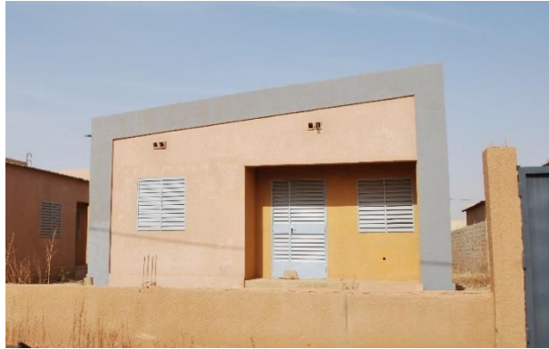
Figure 2-9 : Logement de bon standing
