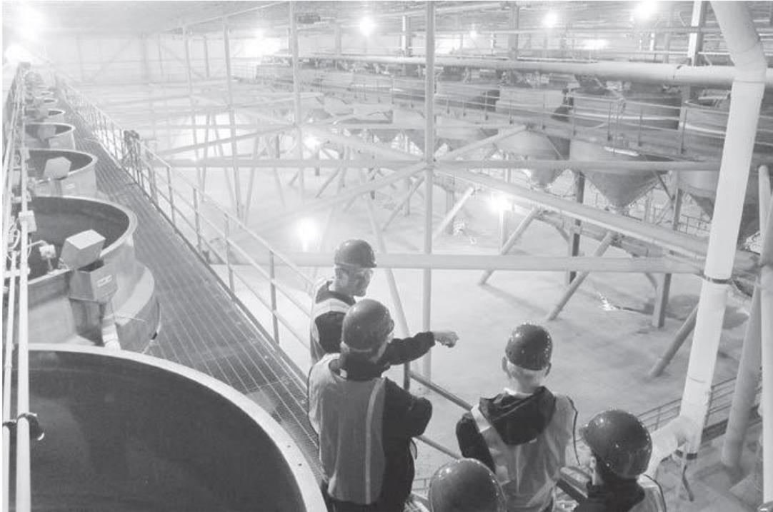
*Ill. 4.3 : Les cuves de trempages d'une malterie moderne. 12 cuves sont utilisées pour 200 tonnes de malt. Les boîtes Saladin sont situées juste en dessous des cuves de trempage.*
