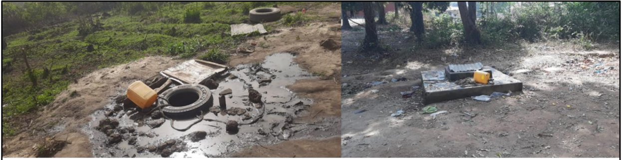
Puits d'eau dans le lit de la rivière à Kouria
