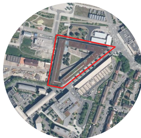
Figure n°97 : Zoom sur les toitures végétalisées de l'établissement scolaire de Guy Debeyre à Dunkerque. Photographie (Géoportail). Réalisation personnelle, 2024
