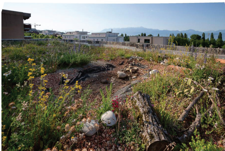
Figure n°3 : Photographie de toiture végétalisée biodiverses sur les halles de Beaulieu à Lausanne. Auteur : (Benoît Renevey, 2013).
