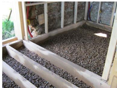
Figure 101 : Exemple d'isolation en coquillage -Infogreen
