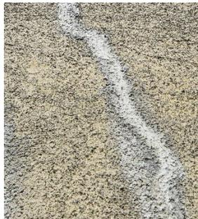
Figure 70: Fissure réparée sur la façade – photo R.Fransolet
