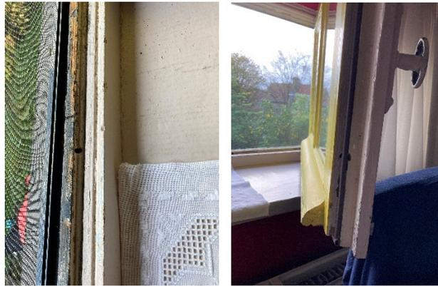
Figure 65: Châssis de fenêtre en l'état avec quincailleries anciennes - photo R. Fransolet
