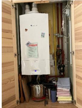
Figure 69: Chaudière de l'habitation dissimulée dans un meuble de cuisine- photo R.Fransolet
