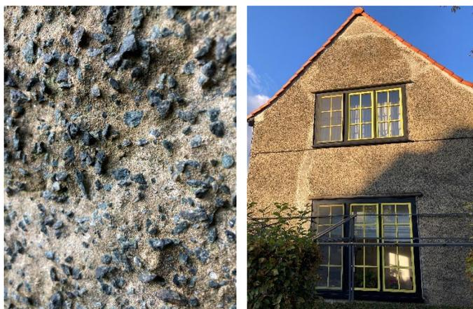
Figure 72: Enduit de finition extérieure présent sur l'habitation – photo R. Fransolet
