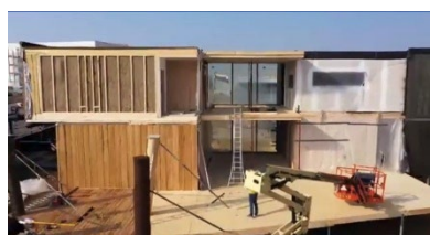
Figure 116 : Réalisation d'une isolation en fibres d'herbe Namur-Belgique - Gramitherm
