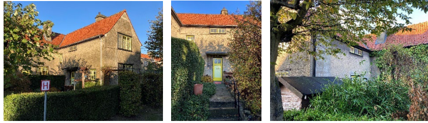
Figure 54: Photographies R. Fransolet de la maison étudiée
