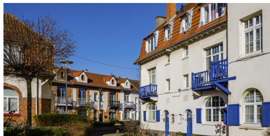
Figure 30 : Habitations de la cité de Diongre- visit.brussels
