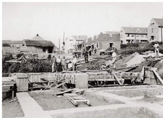
Figure 36: Photo de chantier de l'époque - Source : Archive du CIVA
