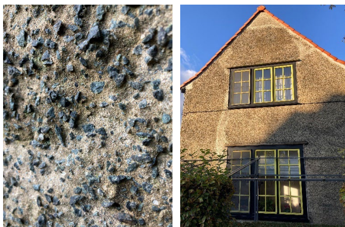
Figure 72: Enduit de finition extérieure présent sur l'habitation – photo R. Fransolet
