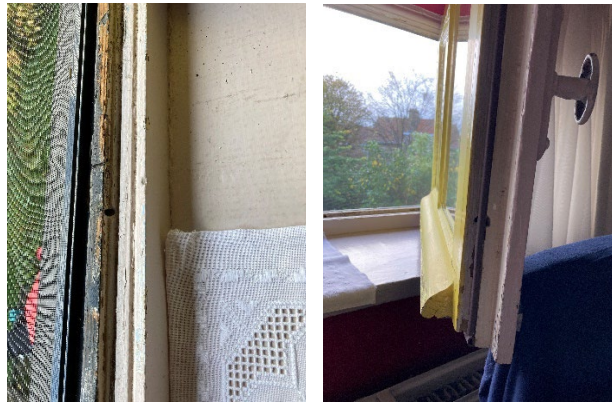
Figure 65: Châssis de fenêtre en l'état avec quincailleries anciennes - photo R. Fransolet
