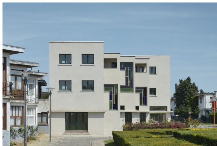
Figure 98: Situation après travaux - Origin
