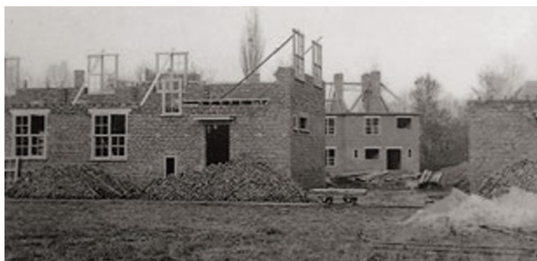
Figure 42: Photo de chantier de l'époque - Source : Eggericx&Hanosset
