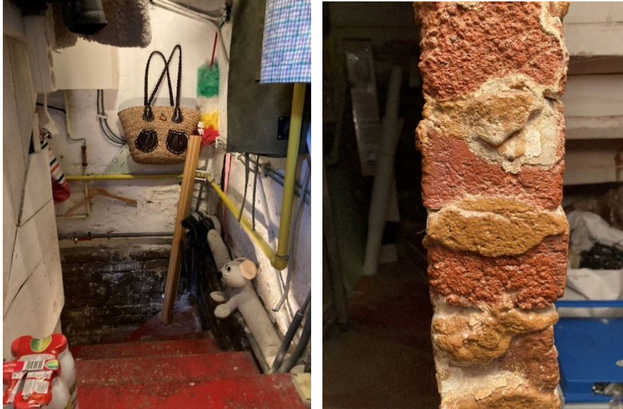
Figure 58: Escaliers menant à la cave -photo R. Fransolet
