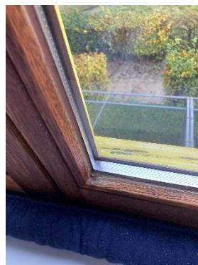
Figure 66: Châssis double vitrage fin remplacé -photo R. Fransolet
