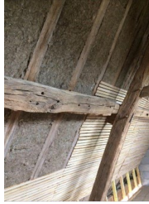
Figure 90 : Réalisation d'une isolation en fibres d'herbe Ons-en-Bray – France - Gramitherm
