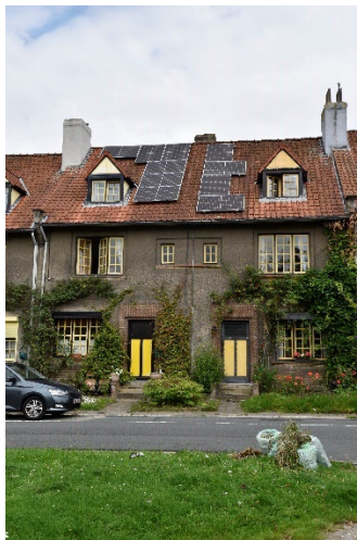
Figure 86 : Toiture avec panneaux photovoltaïques non-autorisés - Photo R.Fransolet
