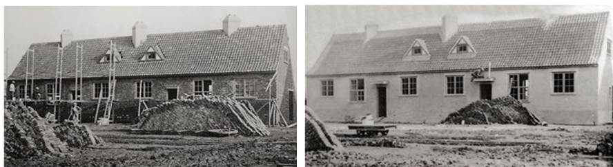
Figure 44: Photos de chantier de l'époque - Source : Eggericx&Hanosset
