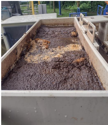
Figure 28 : photo du dessus du décanteur lamellaire après 5 heures de fonctionnement
