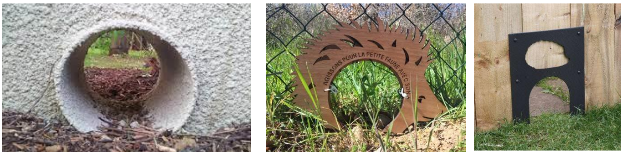
Figure 59 : Exemples de passage d'ouvertures ponctuelles dans des murs et clôtures © Hedgehog Street
