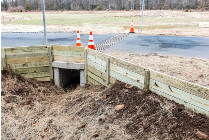
Figure 122 : Exemple d'un tunnel pour la petite faune © Newjerseyhills.com
