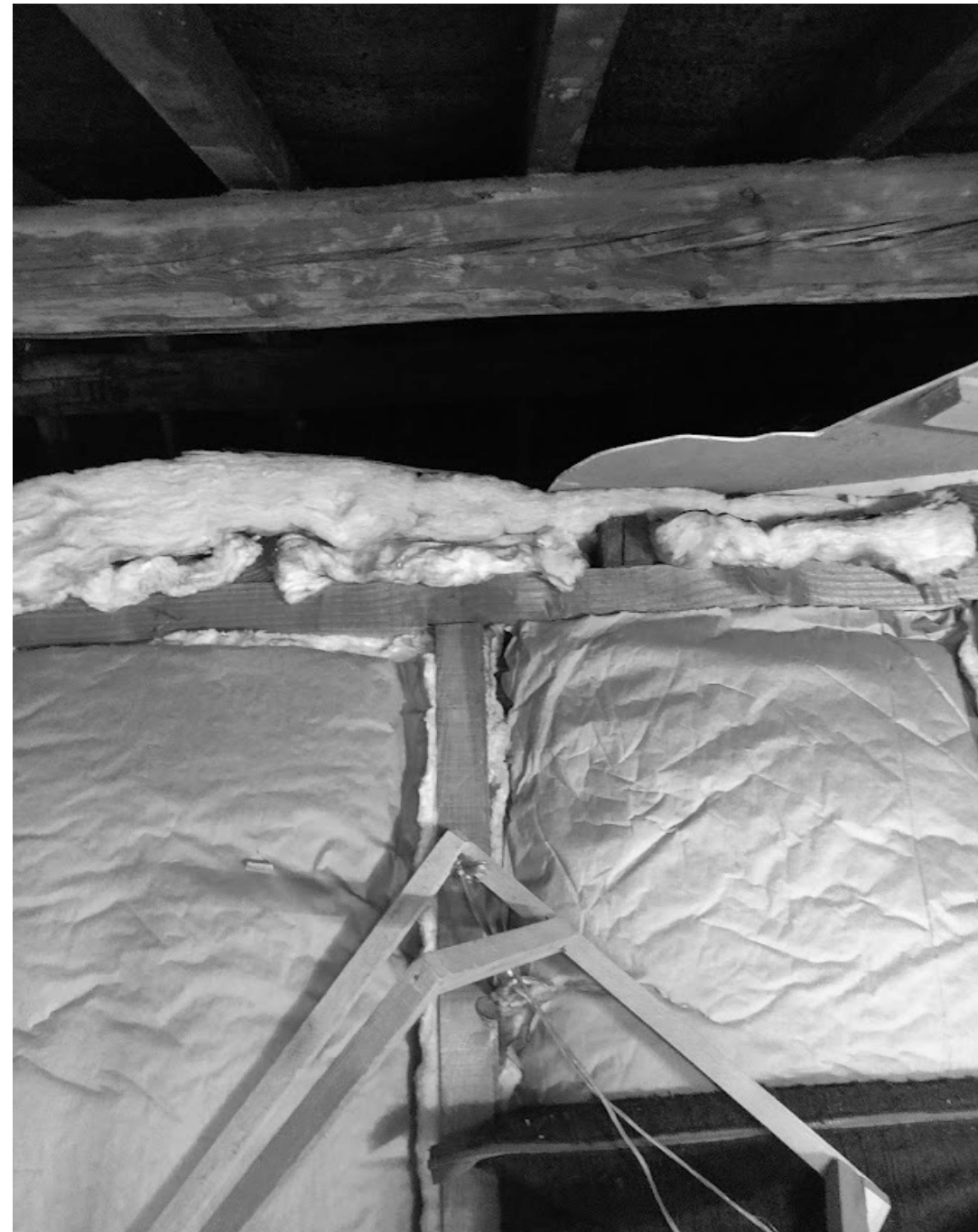
ill54 Photographie de l'isolation en matelas de laine de roche du plancher sous les combles et de la paroi du grenier au deuxième étage du corps de maison (Réalisation personnelle, 2024).
