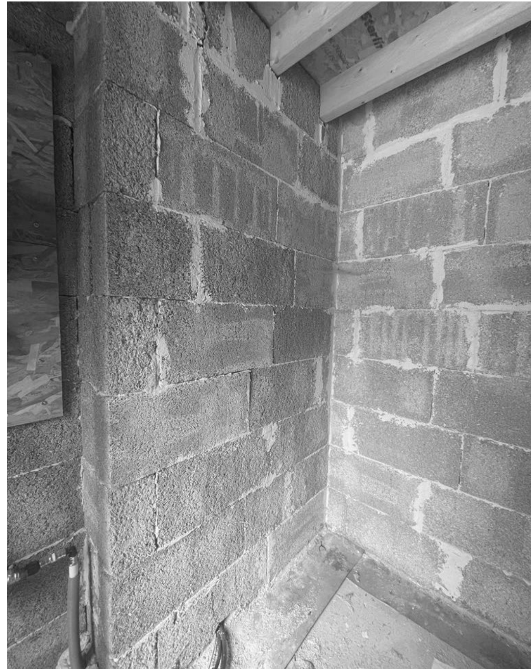
ill29 Murs en blocs de chanvre maçonnés à l'aide d'un mortier colle à base de chaux. Il s'agit du chantier de rénovation d'une fermette de monsieur Nelles (Réalisation personnelle, 2024).
