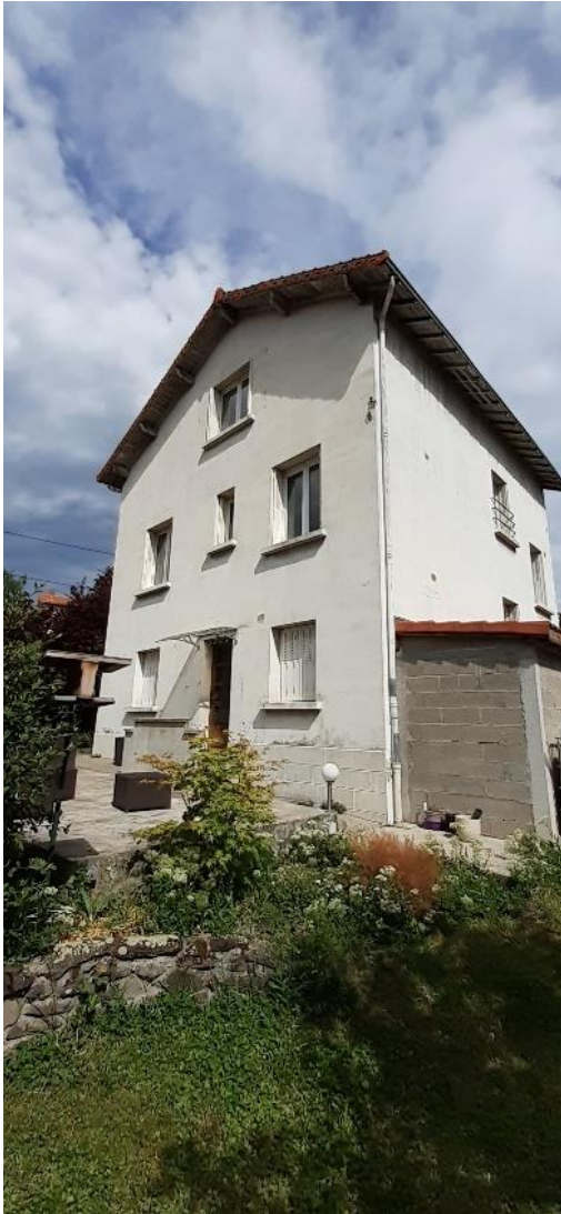
Figure 48 - Photo de la maison de M.S. avant travaux - réalisée par le technicien SOLIHA
