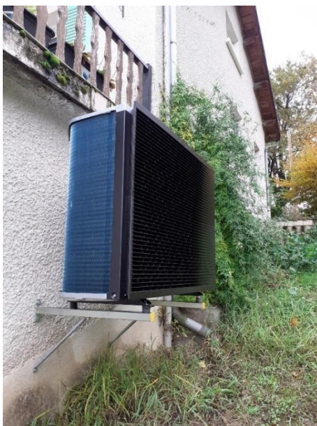
Figure 38 - Photos de la pompe à chaleur installée - réalisées par mes soins
