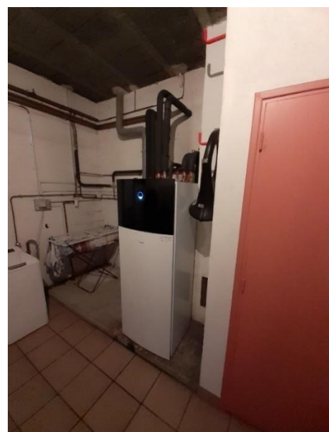
Figure 38 - Photos de la pompe à chaleur installée - réalisées par mes soins
