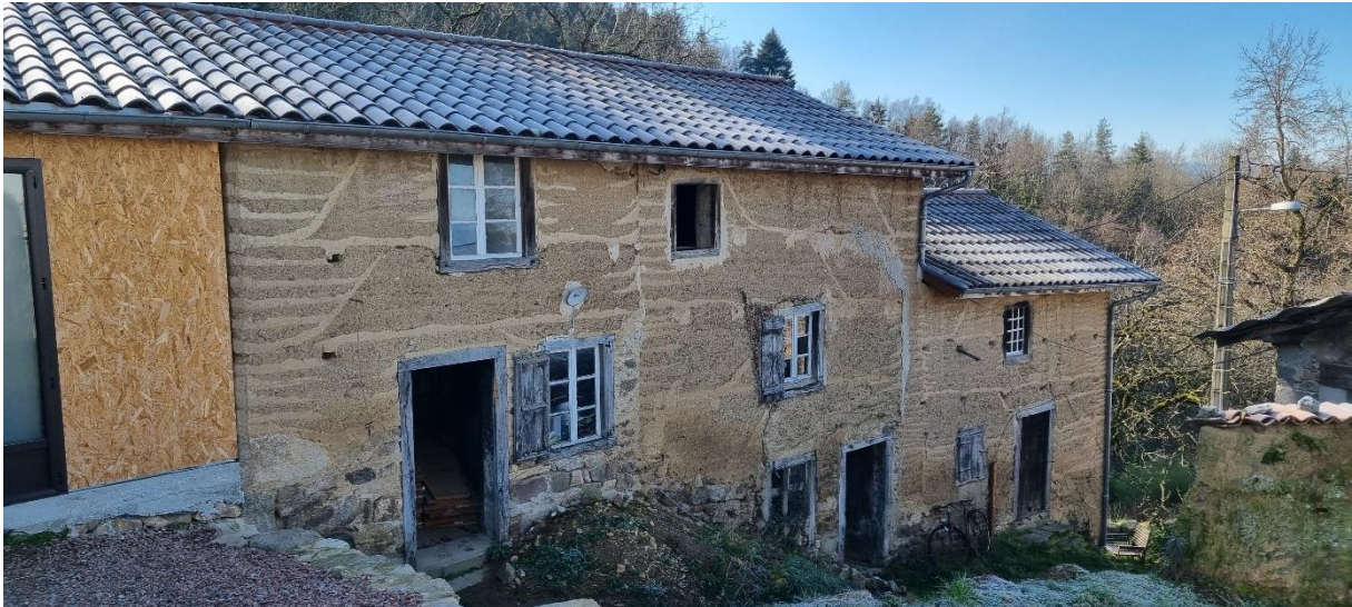
Figure 45 - Photo de la maison de M. et Mme R. - réalisée par le technicien SOLIHA
