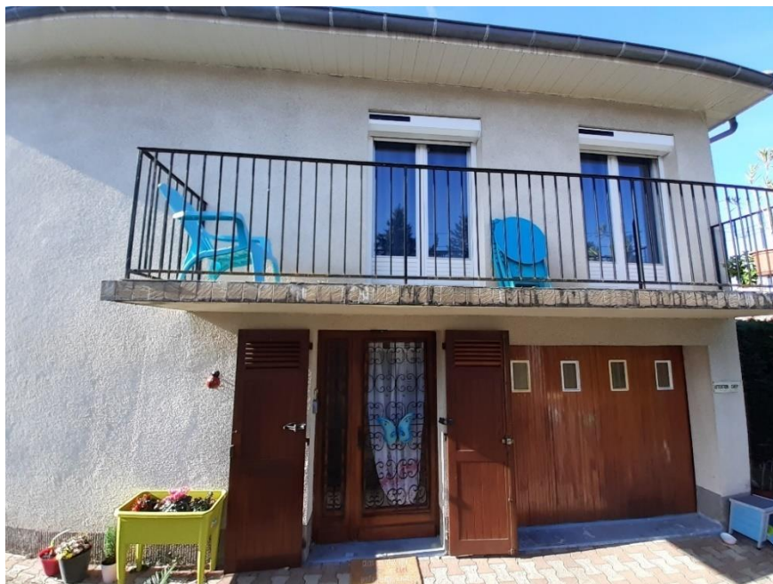
Figure 42 - Photos de la maison de Mme V. - réalisées par mes soins
