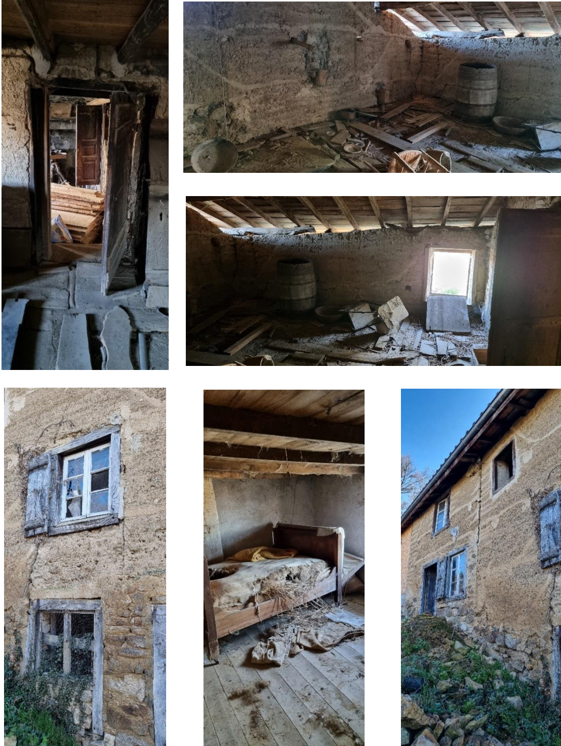
Figure 47 - Photos de la situation actuelle de la maison- réalisées par le technicien SOLIHA
