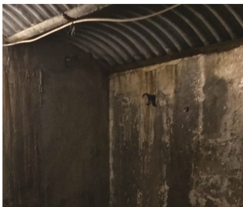
Figure 14 : Photo personnelle montrant un coffrage en tôle ondulée au fort de Flémalle, septembre 2022
