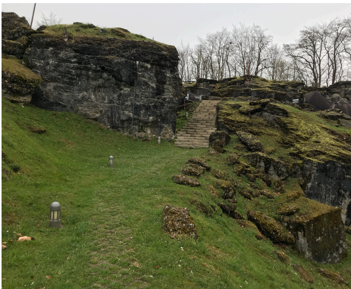
Figure 26 : Photo personnelle montrant une section du béton qui formait autrefois le massif central du fort de Loncin, avril 2022
