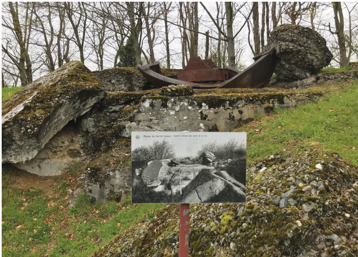
Figure 33 : Photo personnelle montrant la ruine d'une des coupoles à éclipses pour canon de 5.7 cm du fort de Loncin, avril 2022
