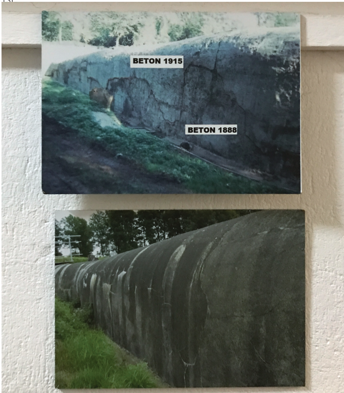
Figure 13 : Photo personnelle d'un affichage montrant les distinctions du béton allemand utilisé pendant la Grande Guerre au fort de Lantin, juillet 2022
