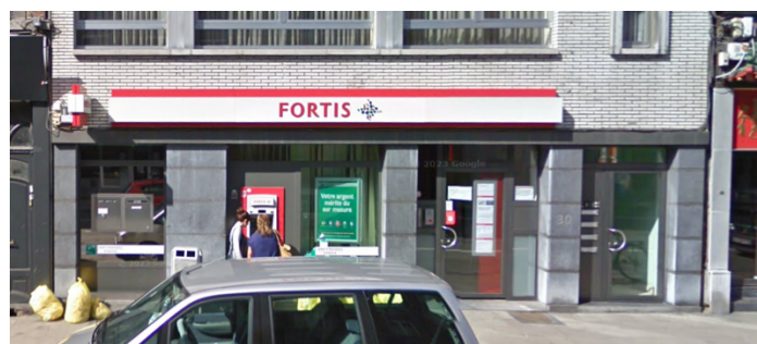
Fig. 62. Photo d'un bâtiment de banque, rue Grétry : 2009.
