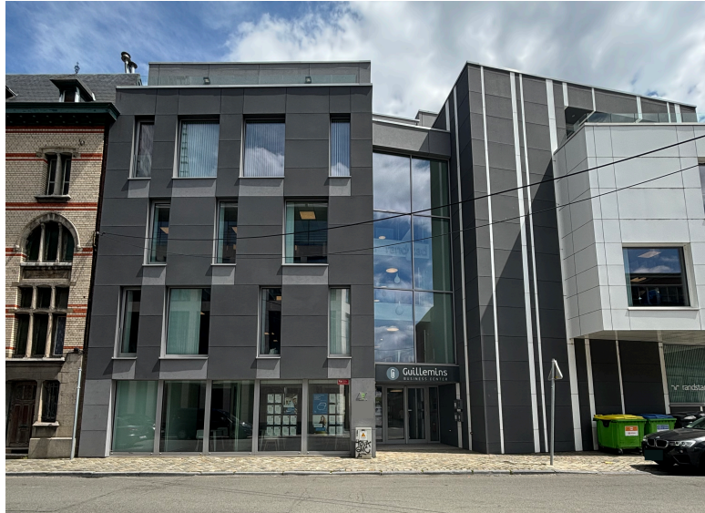
Fig. 70. Photo des bureaux « Guillemins Business Center », rue de Fragnée.
