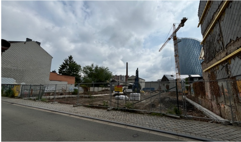
Fig. 34. Photo d'une parcelle en chantier, rue de Serbie.
