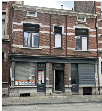
Fig. 36. Photo d'un bâtiment en chantier, rue des 22.
