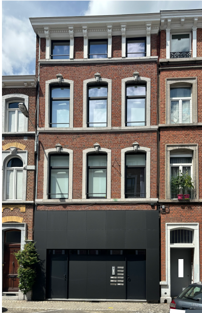
Fig. 46. Photo d'un portail d'entrée, rue de l'État-tiers.
