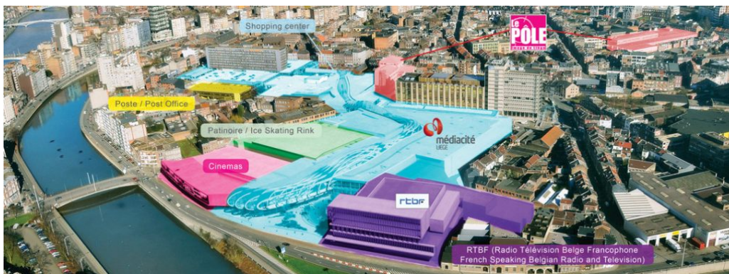
Fig. 17. Photo aérienne de l'ensemble du site de la Médiacité.
