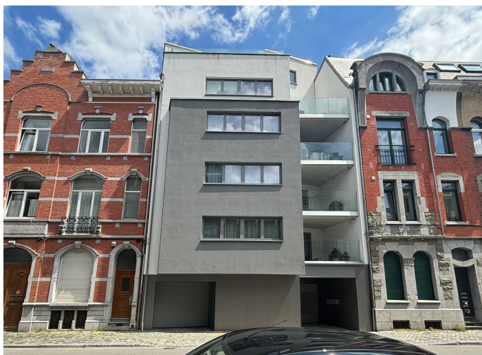
Fig. 39. Photo d'une nouvelle habitation, rue de Fragnée.
