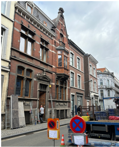
Fig. 35. Photo d'un bâtiment en chantier, rue de Serbie.
