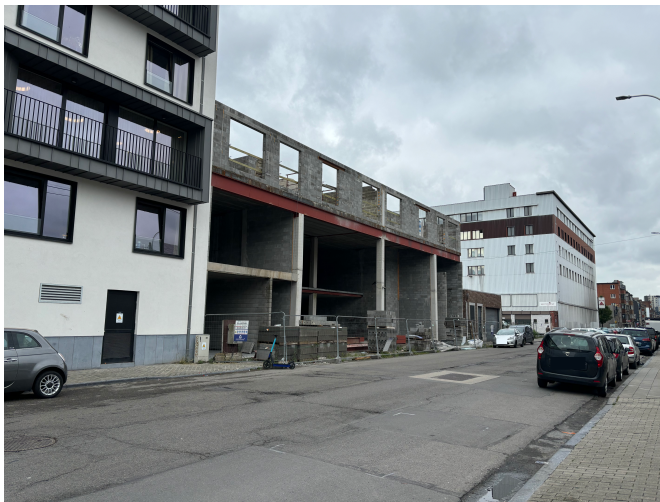
Fig. 37. Photo d'une parcelle en chantier, rue Grétry.
