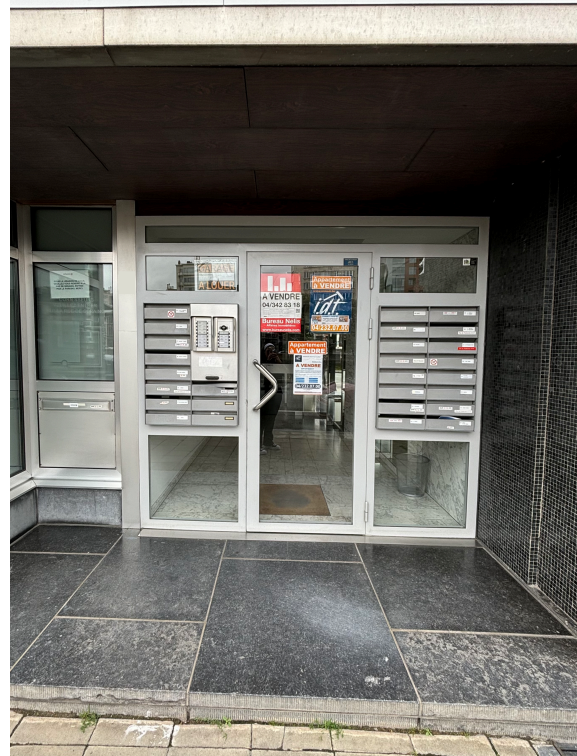
Fig. 51. Photo de la porte d'entrée d'un immeuble, quai Orban.
