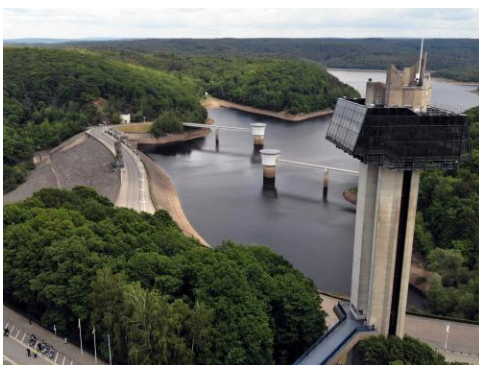
Figure 156 : le barrage de la Gileppe
