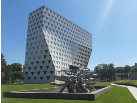
Figure 148 : Bâtiment administratif de la province d'Anvers
