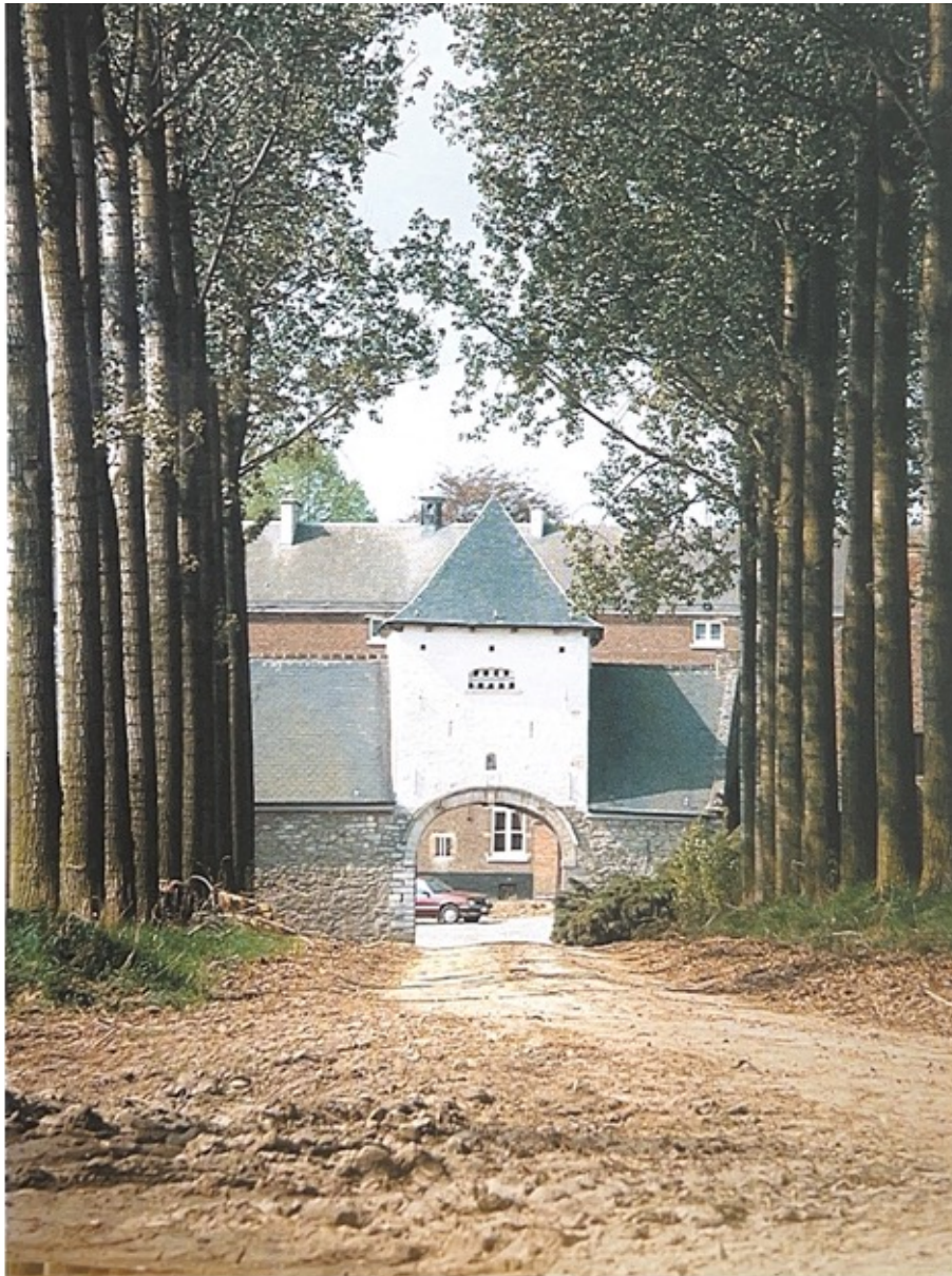
Figure 21 : illustration d'un porche d'entrée d'une ferme à cour à Bossut-Gottechain (HB)– Source © GENICOT, L.-F. & al. (1996)
