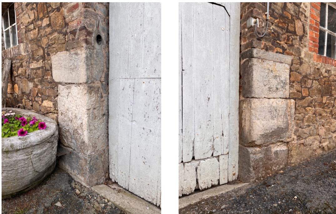
Figure 77 : Illustration des piédroits en pierre calcaire du passage charretier de la grange de la ferme Lemaire – Illustration © Antoine GUSBIN
