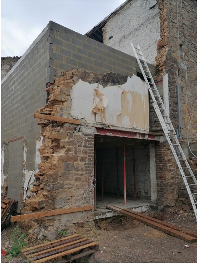
Figure 116 et 117 : illustrations de la composition d'un mur en travaux du projet au Transvaal – Illustration © Antoine GUSBIN
