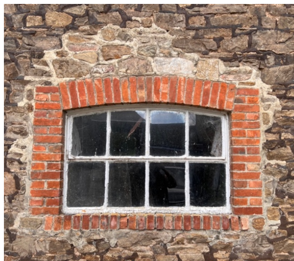
Figure 83 et 84 : illustrations d'une baie récente, rejointoyée avec un mortier différent de la façade – Illustration © Antoine GUSBIN
