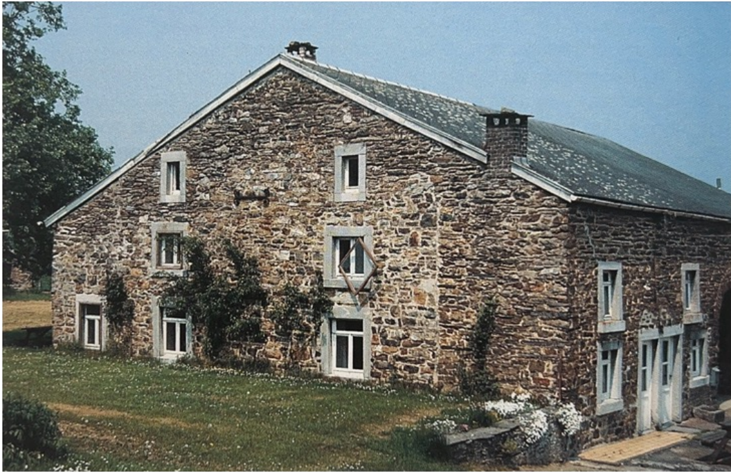
Figure 43 : illustration d'encadrements de baies, réalisés avec un matériau différent, d'une ferme en surface à Rahier (AH) – Source © GENICOT L.-F. & al. (1996)
