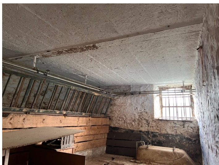
Figure 85 et 86 : illustration des murs enduits de chaux et du plancher à sommiers métalliques – Illustration © Antoine GUSBIN
