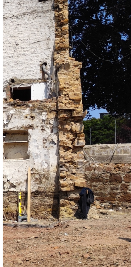
Figure 116 et 117 : illustrations de la composition d'un mur en travaux du projet au Transvaal – Illustration © Antoine GUSBIN
