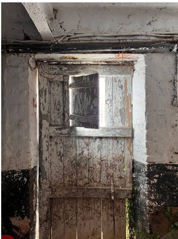
Figure 93 : illustration des murs enduits de chaux dans l'étable de l'aile Nord-Ouest – Illustration © Antoine GUSBIN
