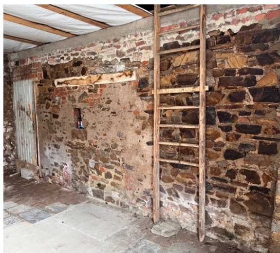
Figures 81 et 82 : illustrations des murs du passage charretier composés de briques et de moellons – Illustration © Antoine GUSBIN
