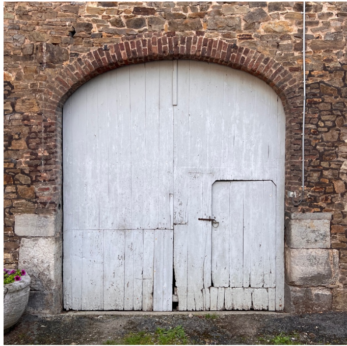
Figure 76 : illustration de la matérialité de la façade Nord-Est de la grange de la ferme Lemaire – Illustration © Antoine GUSBIN
