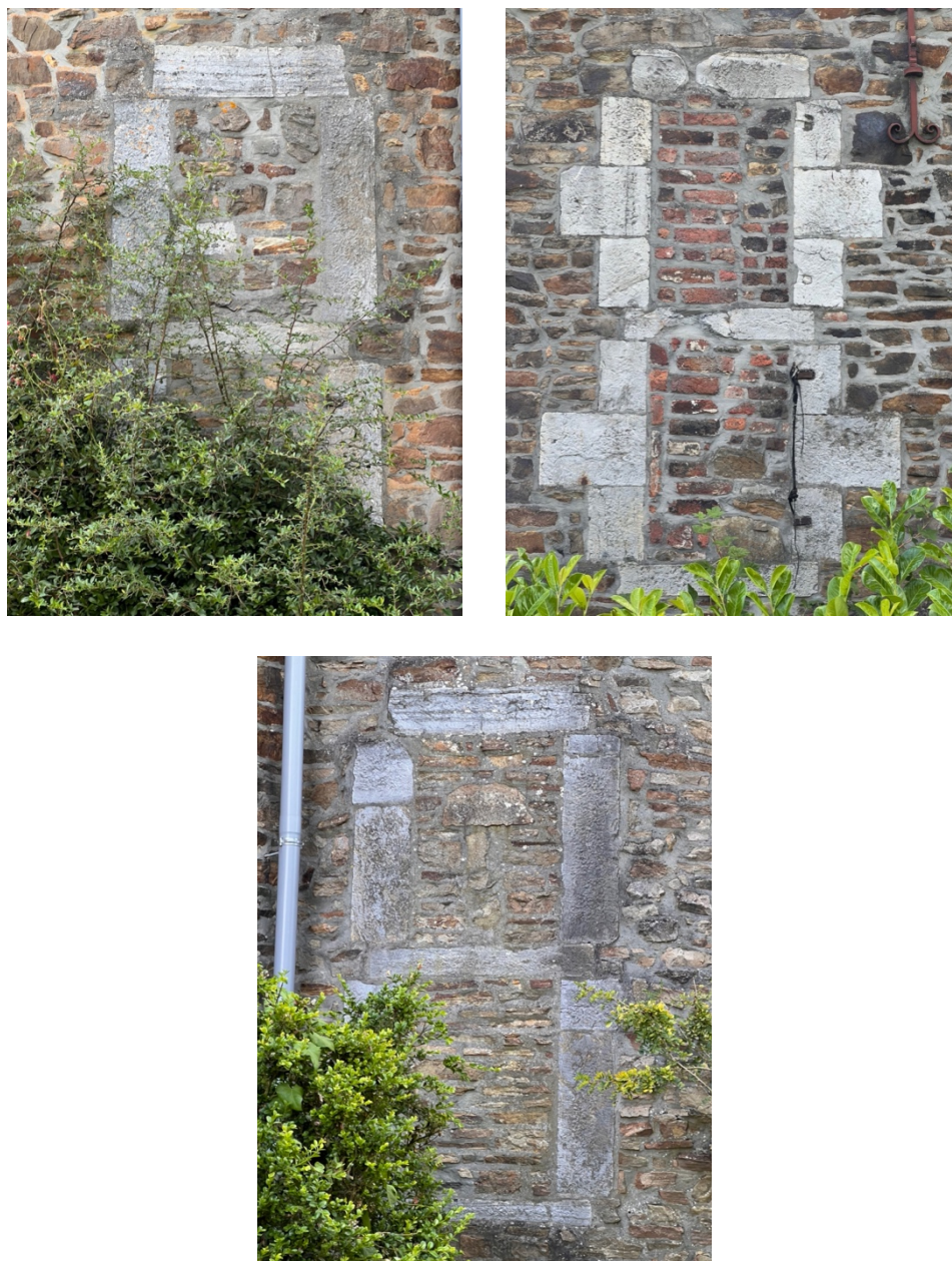
Figure 72 : illustration de baies murées sur la façade Sud-Est de la ferme Lemaire – Illustration © Antoine GUSBIN
