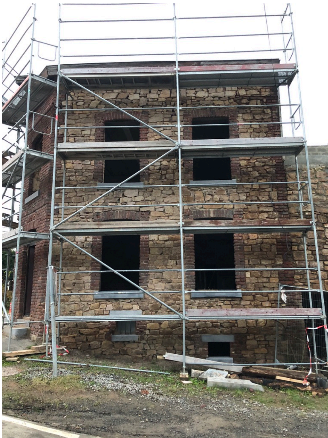
Figure 115 : illustration d'une façade en travaux du projet au Transvaal – Illustration © Antoine GUSBIN
