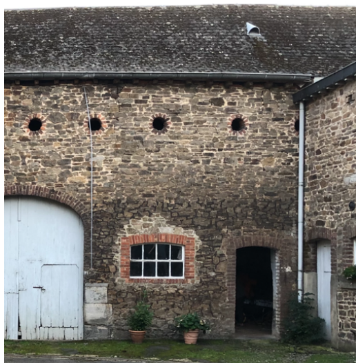
Figure 83 et 84 : illustrations d'une baie récente, rejointoyée avec un mortier différent de la façade – Illustration © Antoine GUSBIN
