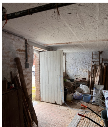
Figure 85 et 86 : illustration des murs enduits de chaux et du plancher à sommiers métalliques – Illustration © Antoine GUSBIN
