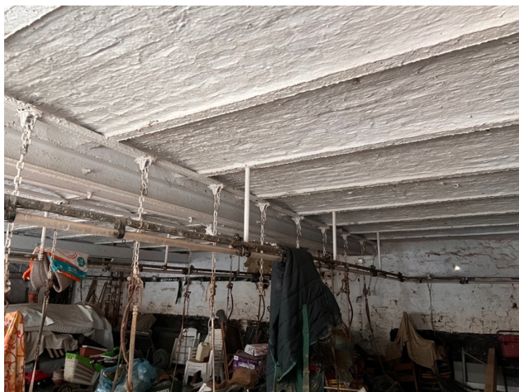
Figure 92 : illustration du plancher à sommiers métalliques dans l'étable de l'aile Nord-Ouest – Illustration © Antoine GUSBIN
