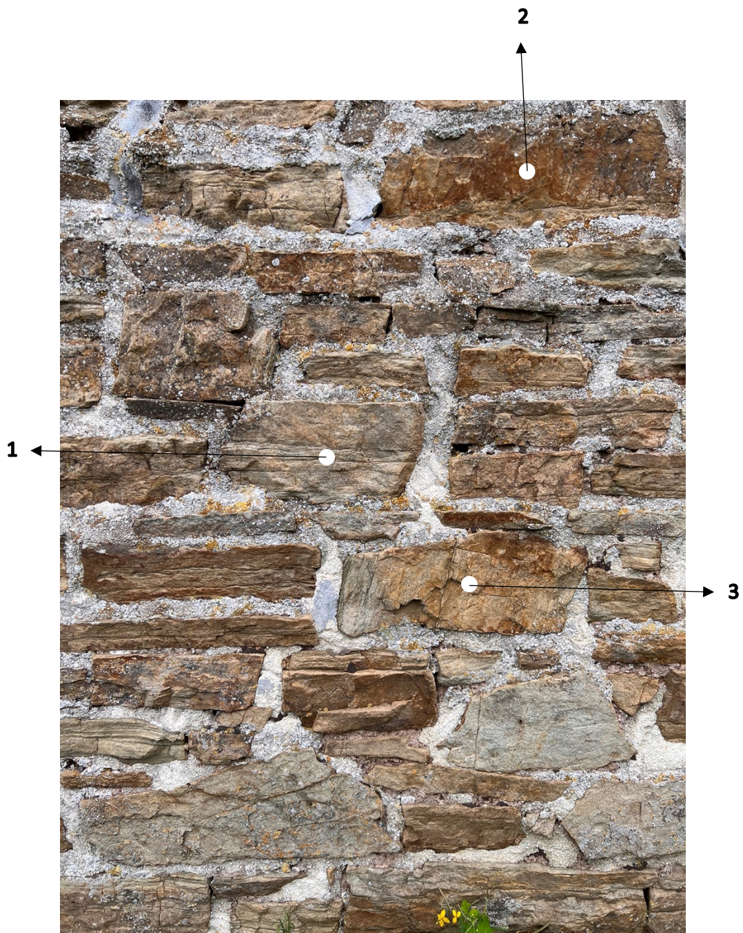
Figure 41 : illustration de pierres en lit (1), en délit parallèle (2) et délit perpendiculaire à la façade (3) sur une façade du cas d'étude – Illustration © Antoine GUSBIN
