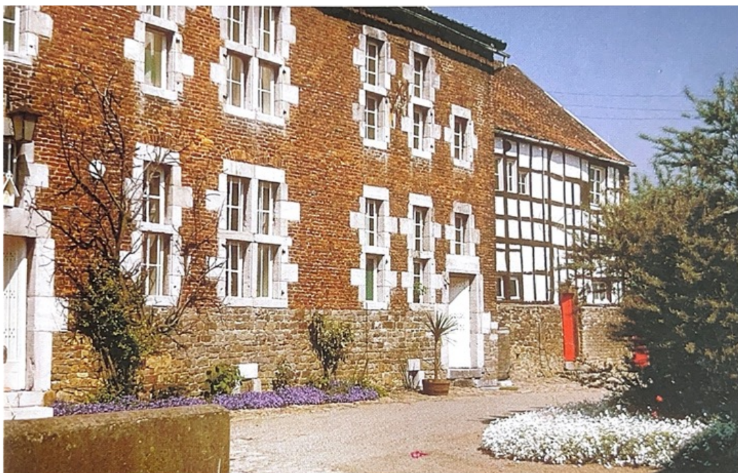
Figure 38 : illustration d'un mur de soutènement en pierre d'une ferme en long à Aubel (PH) – Source © JONGHE, S. & al (1996) Pierres à bâtir traditionnelles de la Wallonie
