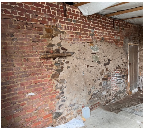
Figures 81 et 82 : illustrations des murs du passage charretier composés de briques et de moellons – Illustration © Antoine GUSBIN
