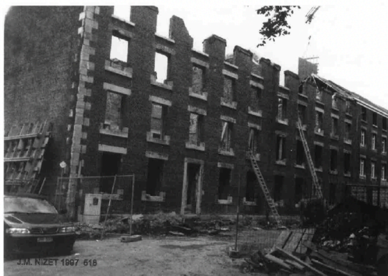
Figure 10 - Photographie de la cité dépourvue de ses éléments structurels, ne laissant que les murs massifs. Source : Nizet, J.M.
