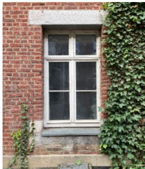
Figure 30 - Zoom sur une baie de fenêtre. Source : Sophie Rulkin.
