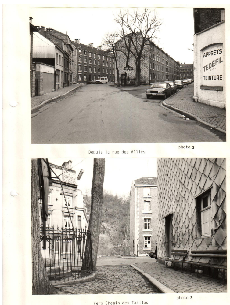
Figure 7 - Photographies des pignons ouest avant les travaux de réhabilitation. Source : Archives de Verviers.
