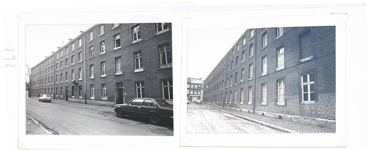
Figure 5 - Photographies des longues façades avant les travaux de réhabilitation. Source : Archives de Verviers.
