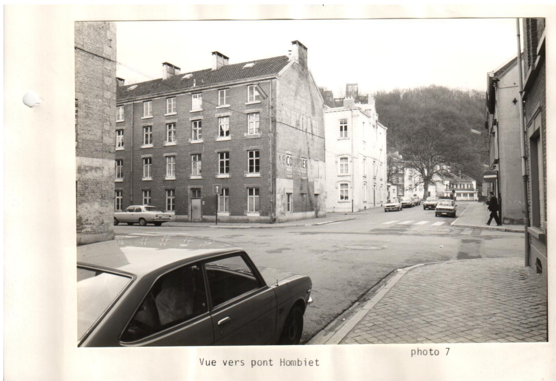
Figure 6 - Photographie des pignons est avant les travaux de réhabilitation. Source : Archives de Verviers.
