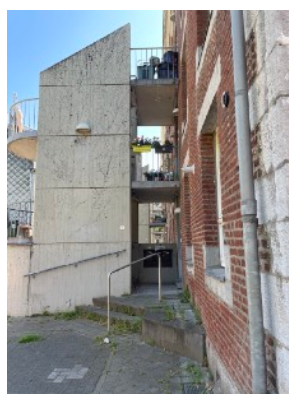
Figure 21 - L'escalier du bloc Nord. Source : Sophie Rulkin.
