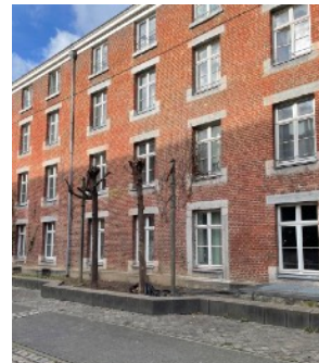
Figure 31 - La façade arrière du bloc Nord. Source : Sophie Rulkin.
