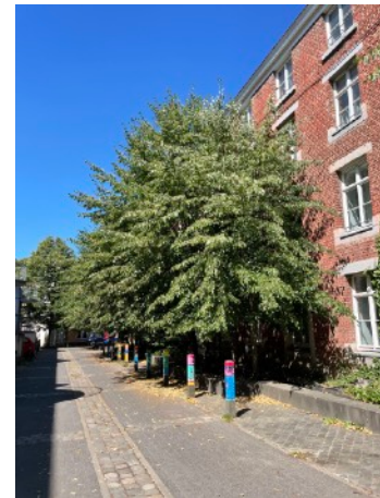
Figure 26 - La façade arrière du bloc Nord en juillet. Source : Sophie Rulkin.
