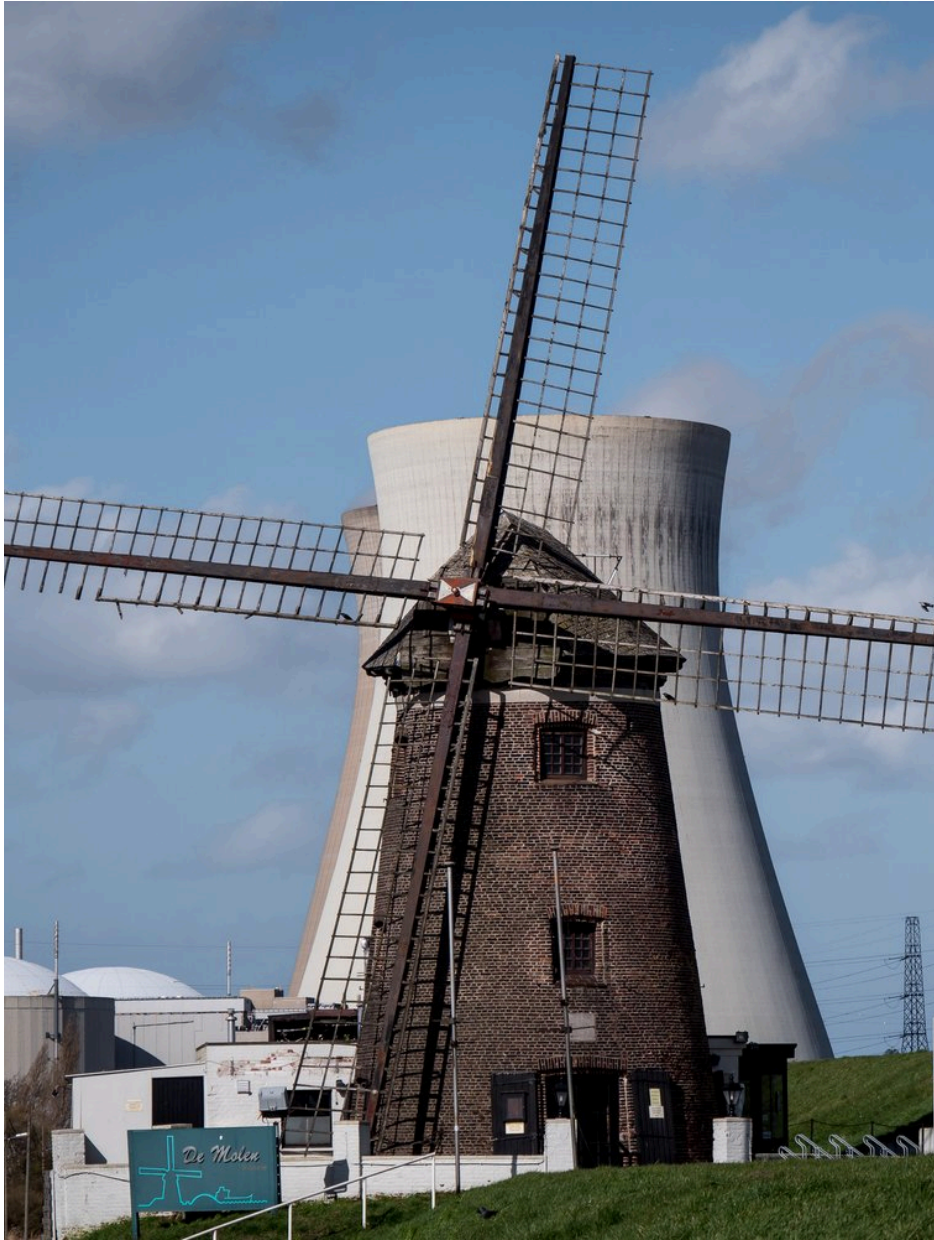
Fig. 19 : photo de la centrale nucléaire et du moulin de Doel. Source : Sucretho. (s.d.). https://www.sucretho.be/doel
