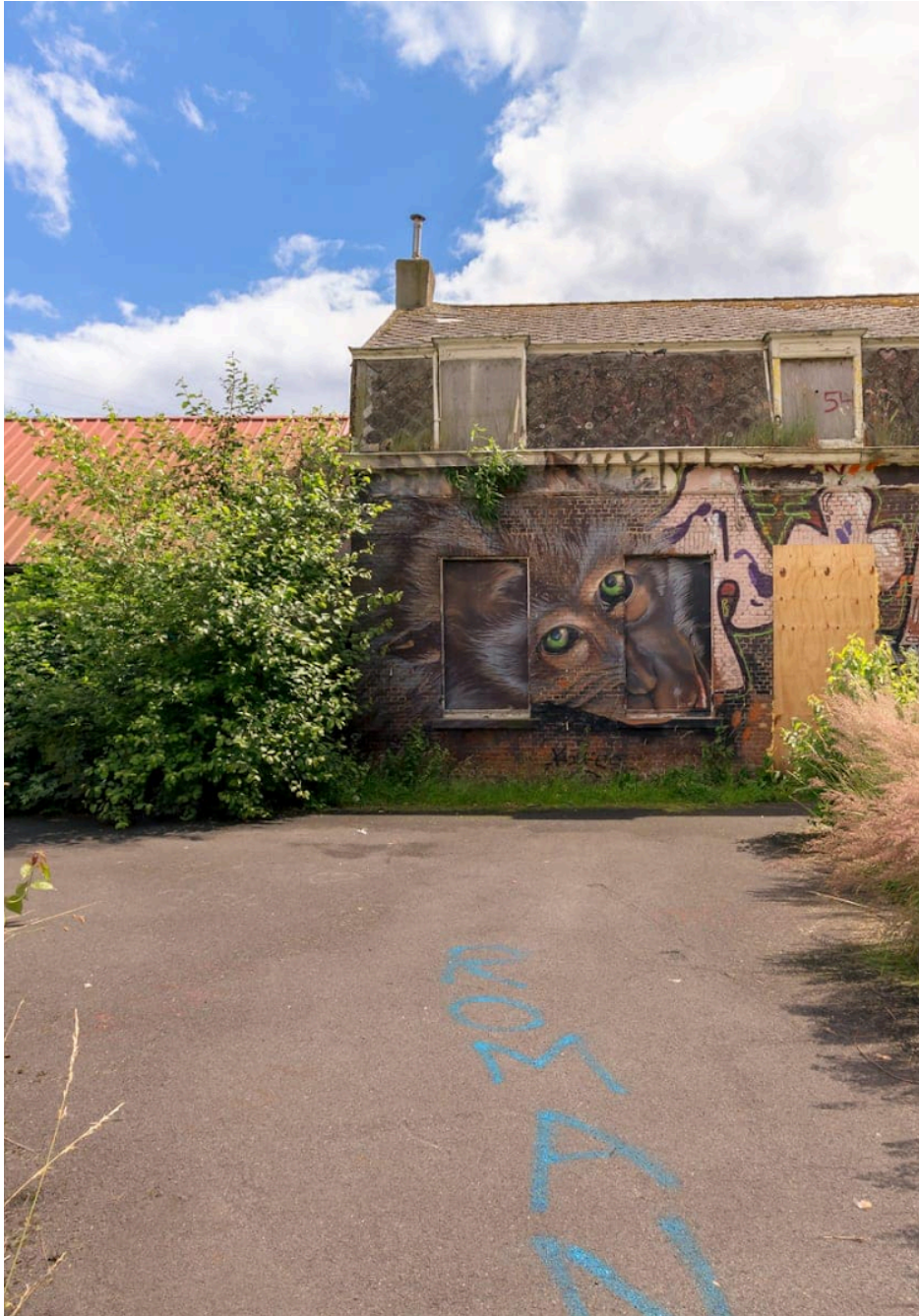
Fig. 45 : photo d'une façade à Doel. Source : Doel . (s. d.). Urbex Session. https://urbexsession.com/doel/
