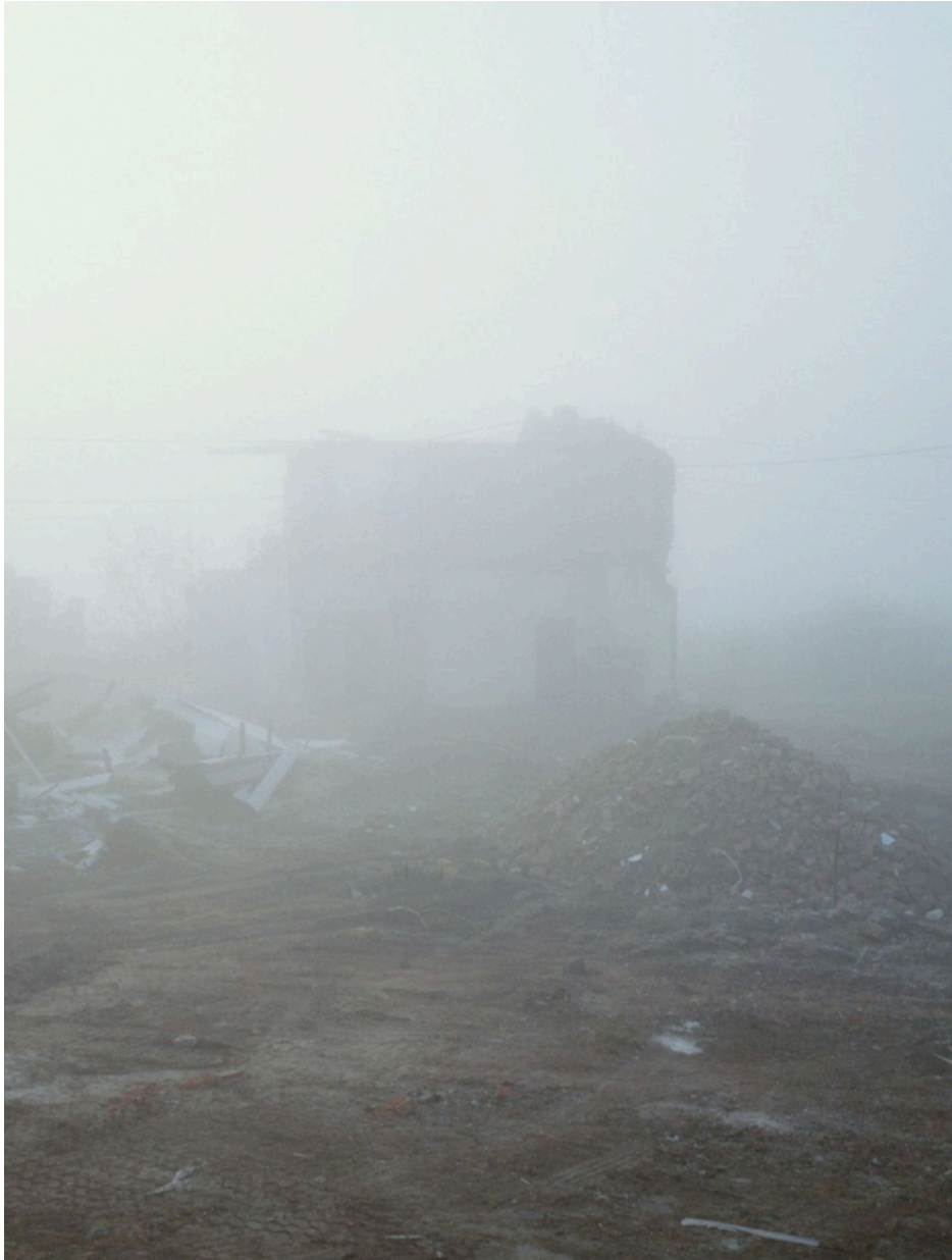
Fig. 35 : photo de démolition à Doel. Source : Pateer, I. (s.d.). Unsettled . Isabelle Pateer Photography. https://www.isabellepateer.com/unsettled
