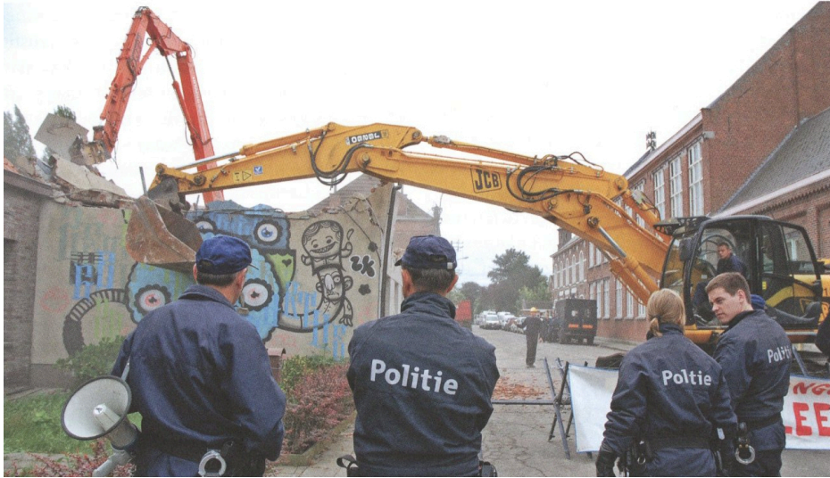
Fig. 12 : Démolition dans le centre de Doel. Source : Creve, J. (2019). Doel 2020: Het gevecht om Doel en de polder , p.55.
