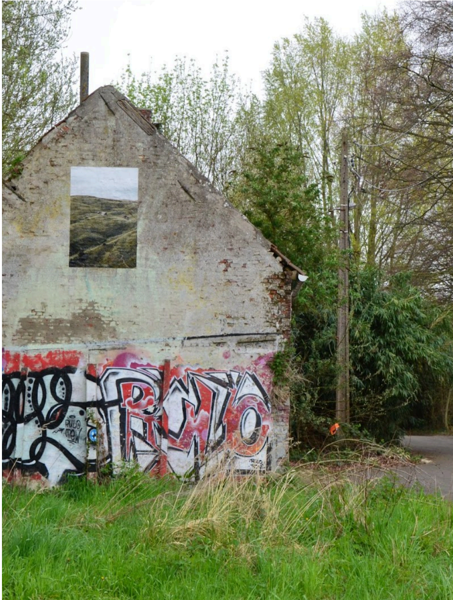
Fig. 44 : photo d'une façade à Doel. Source : Romboux, E. (2023)
