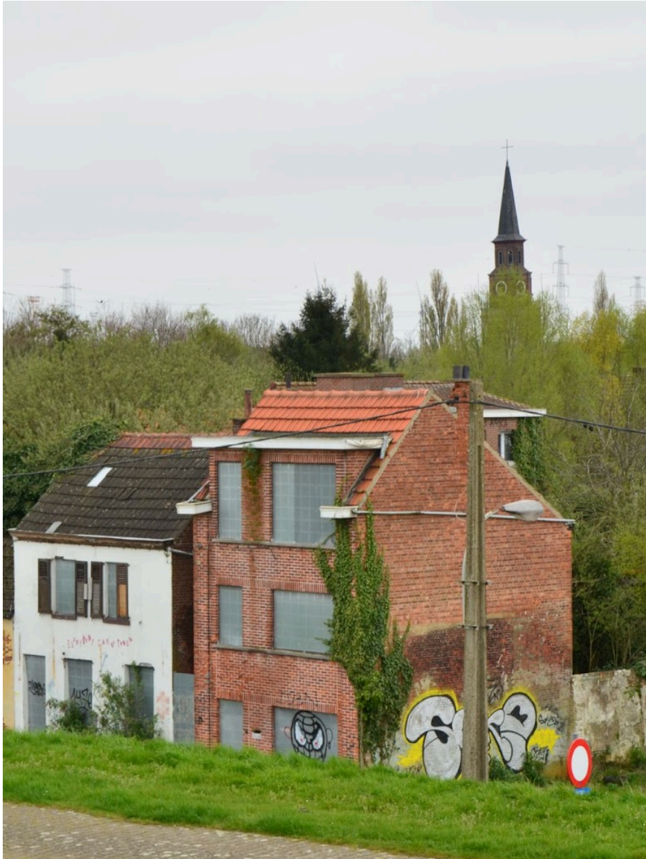
Fig. 30 : photo de maisons à Doel après la mise en place des plaques de fer. Source : Romboux, E. (2023).
