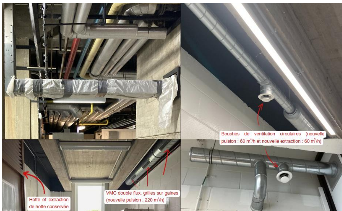
Illustration 32. : Photographies personnelles du système de VMC double flux (R0, R+1, R+3 et R-2).
