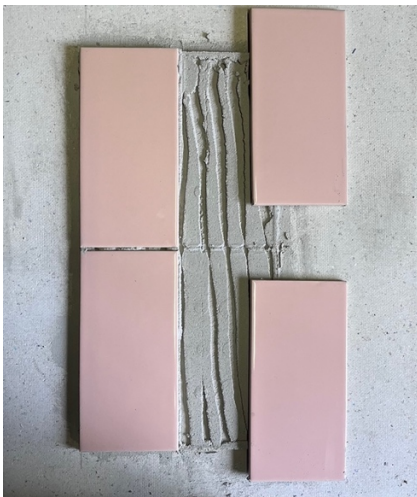
Photo mise en œuvre du Knauf-Mixem
