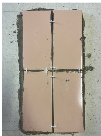
Photo mise en œuvre du mortier-bâtard
