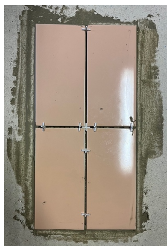
Photo mise en œuvre Kérakoll - Biosouple
