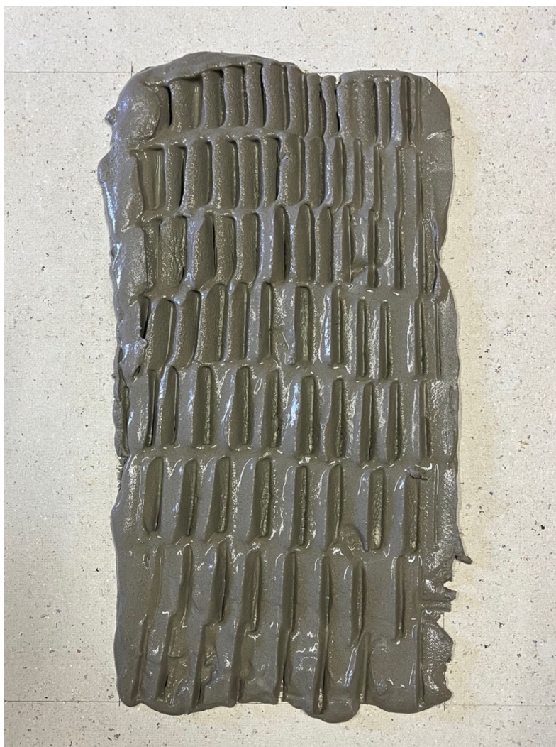
Photo mise en œuvre du mortier-bâtard Observation : le mortier ne se laisse pas peigner
