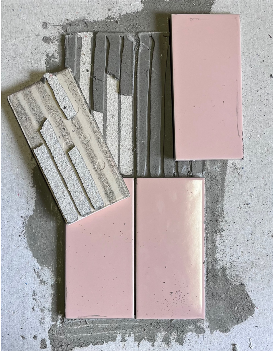
Photo état des carreaux et du mortier-bâtard, pendant le démontage
