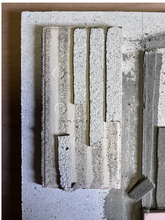
Zoom - État d'un des carreaux posé avec Kérakoll Biosouple, après démontage
