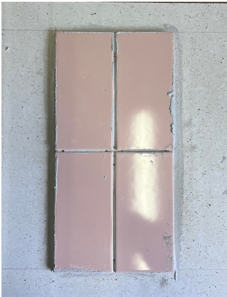
Photo des carreaux mis en œuvre avec du mortier-bâtard
