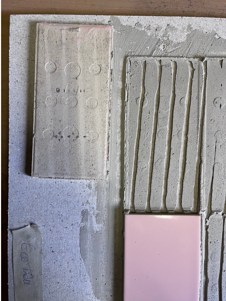
Photo état d'un des carreaux, après démontage
