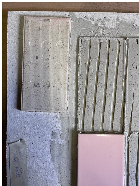
Zoom - État d'un des carreaux posé avec Écobâti, après démontage
