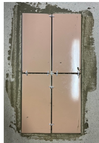
Photo mise en œuvre Kérakoll - Biosouple
