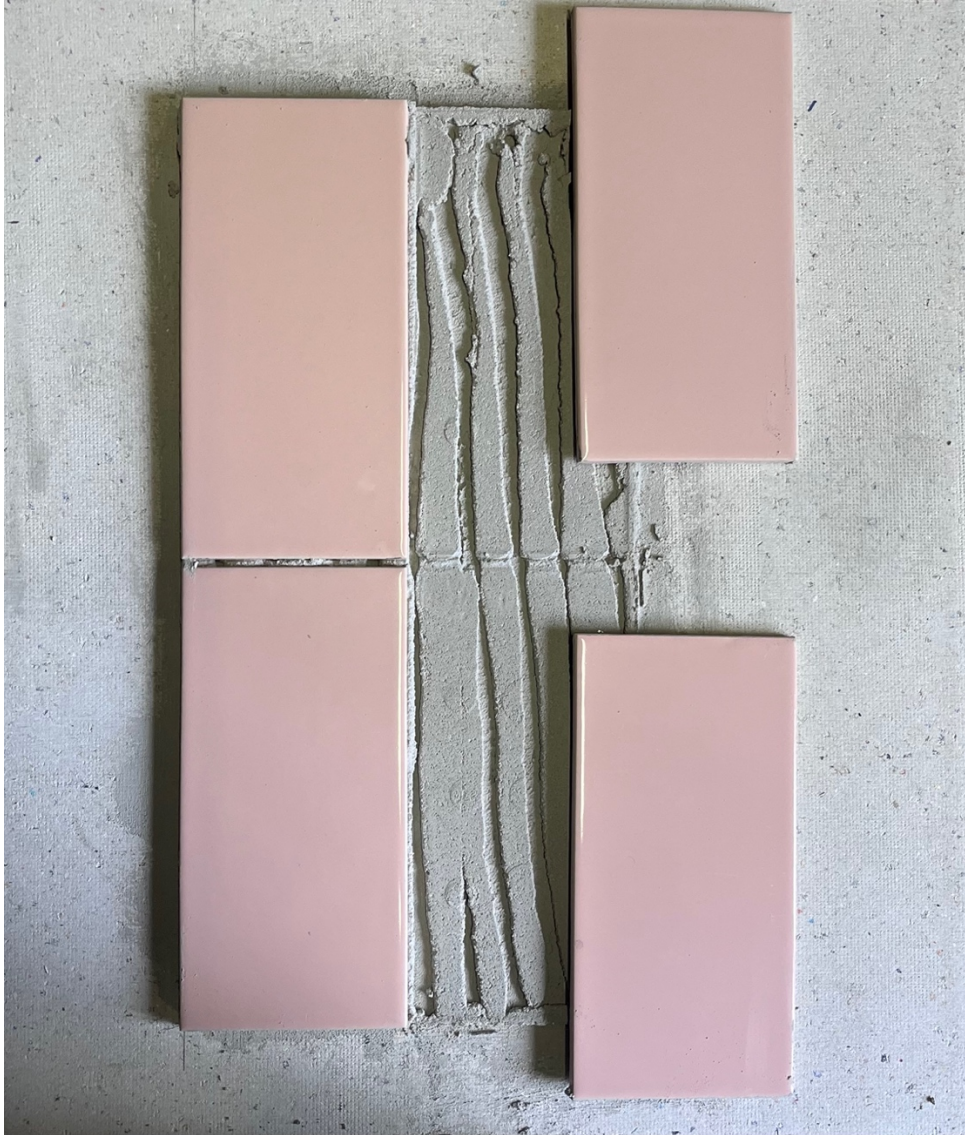
Photo état des carreaux et du mortier-bâtard, après démontage
