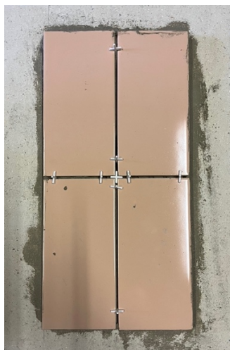
Photo mise en œuvre du Knauf-Mixem
