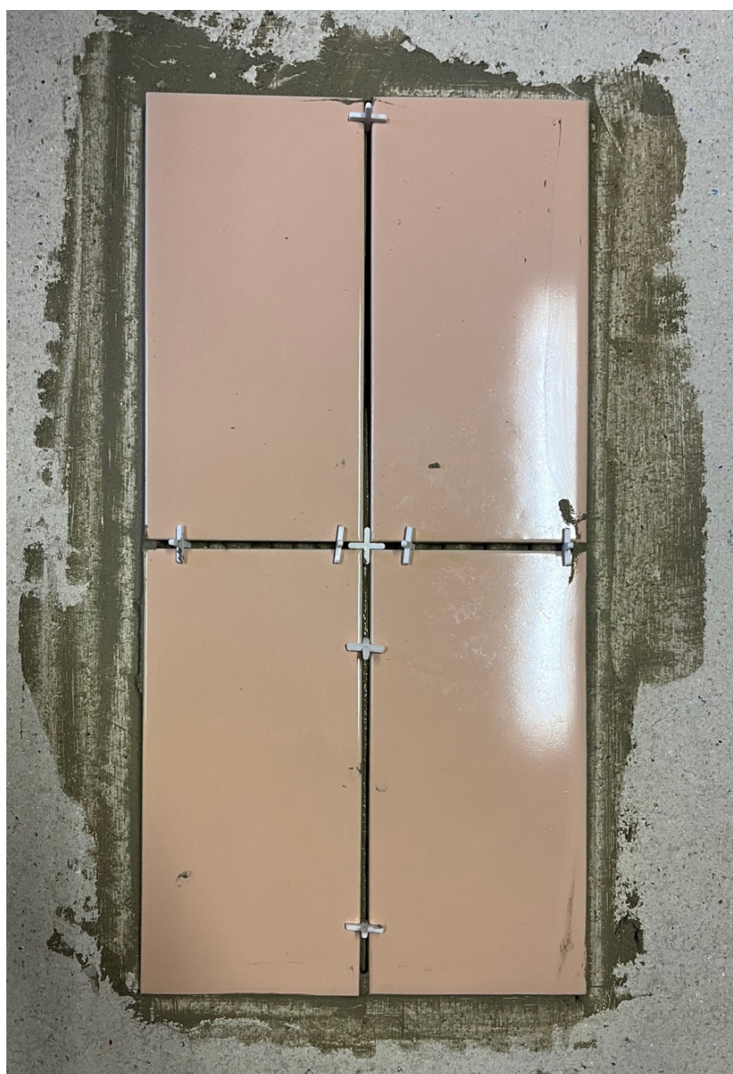
Photo mise en œuvre Kérakoll - Biosouple
