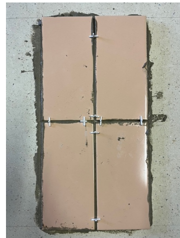
Photo mise en œuvre du mortier-bâtard
