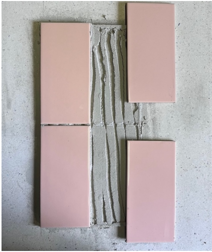
Photo mise en œuvre du Knauf-Mixem
