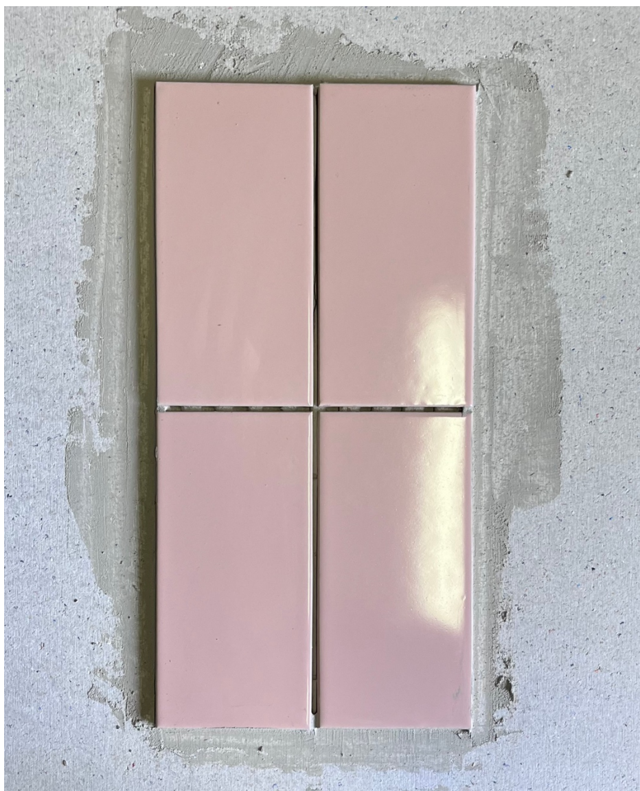
Photo des carreaux mis en œuvre avec du mortier-colle Écobâti
