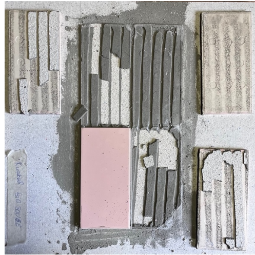
Photo mise en œuvre Kérakoll - Biosouple
