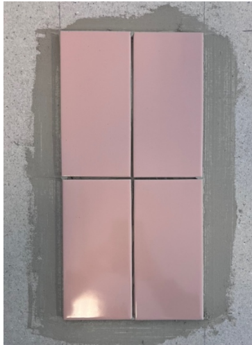
Photo mise en œuvre Ecobâti - Fx930
