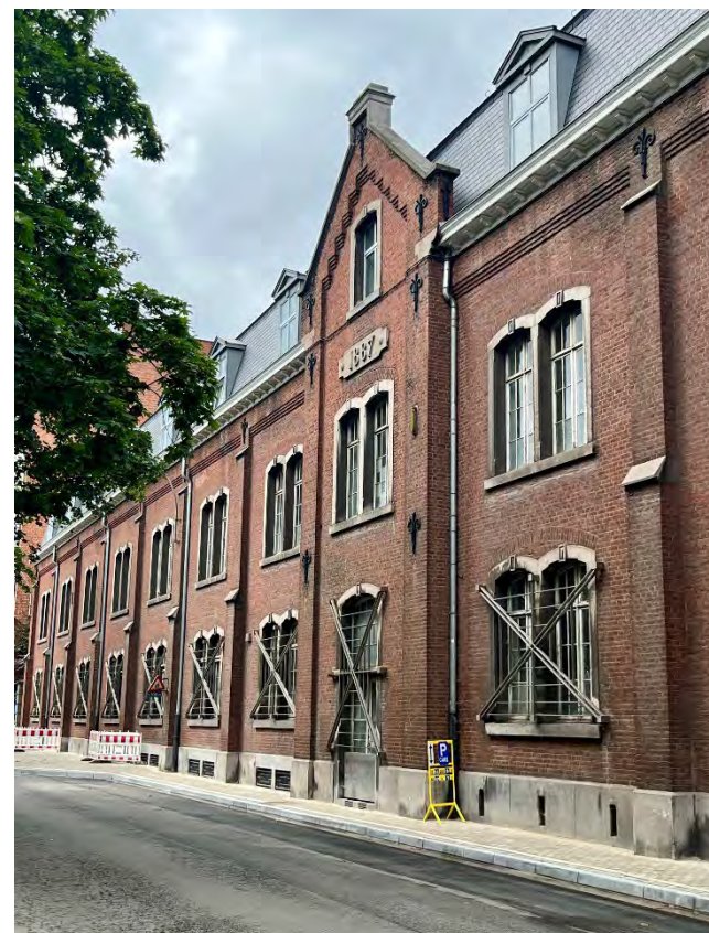
Fig. 77 Photo des croix-de-Saint-André rythmant les baies des façades à rue
