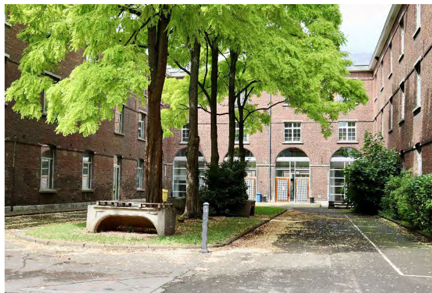
Fig. 71 Photo dévoilant une partie des anciennes constructions militaires construites en 1832
