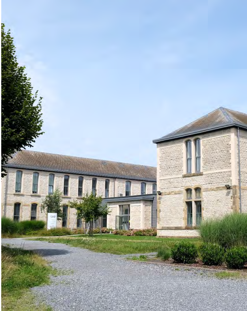
Fig. 29 Extension en zinc reliant les bâtiments 5F et 5G
