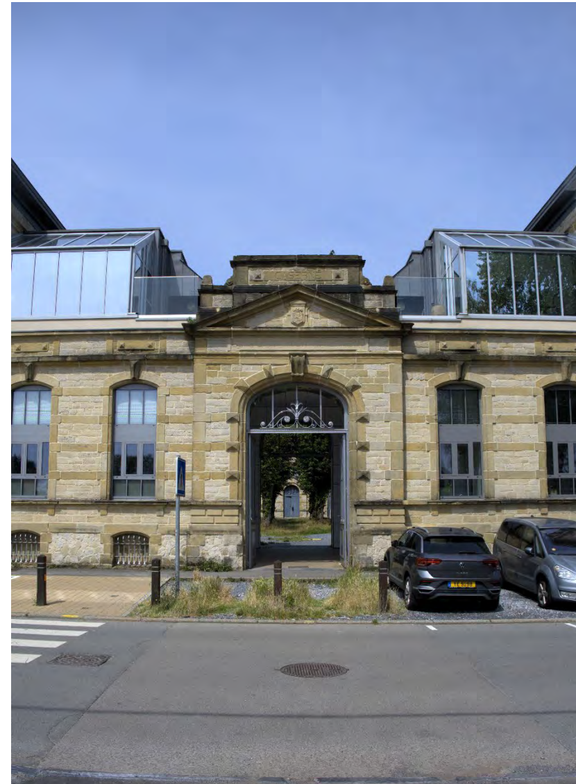
Fig. 28 Portail de l'entrée principale (5A) et ses extensions
