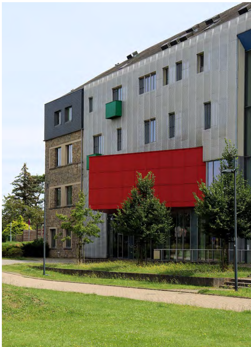
Fig. 21 Intervention marquée du bâtiment réservé à l'Henallux
