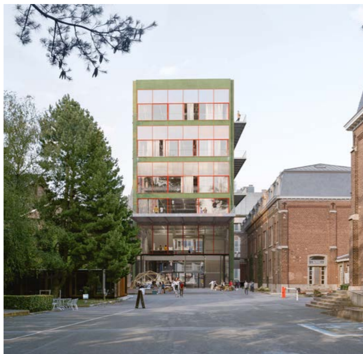
Un bâtiment largement ouvert sur la cour de la caserne Fonck
