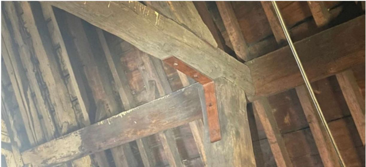
*Figure 16 : Renfort en équerre métallique - Nihant, J., et al., 2022*
