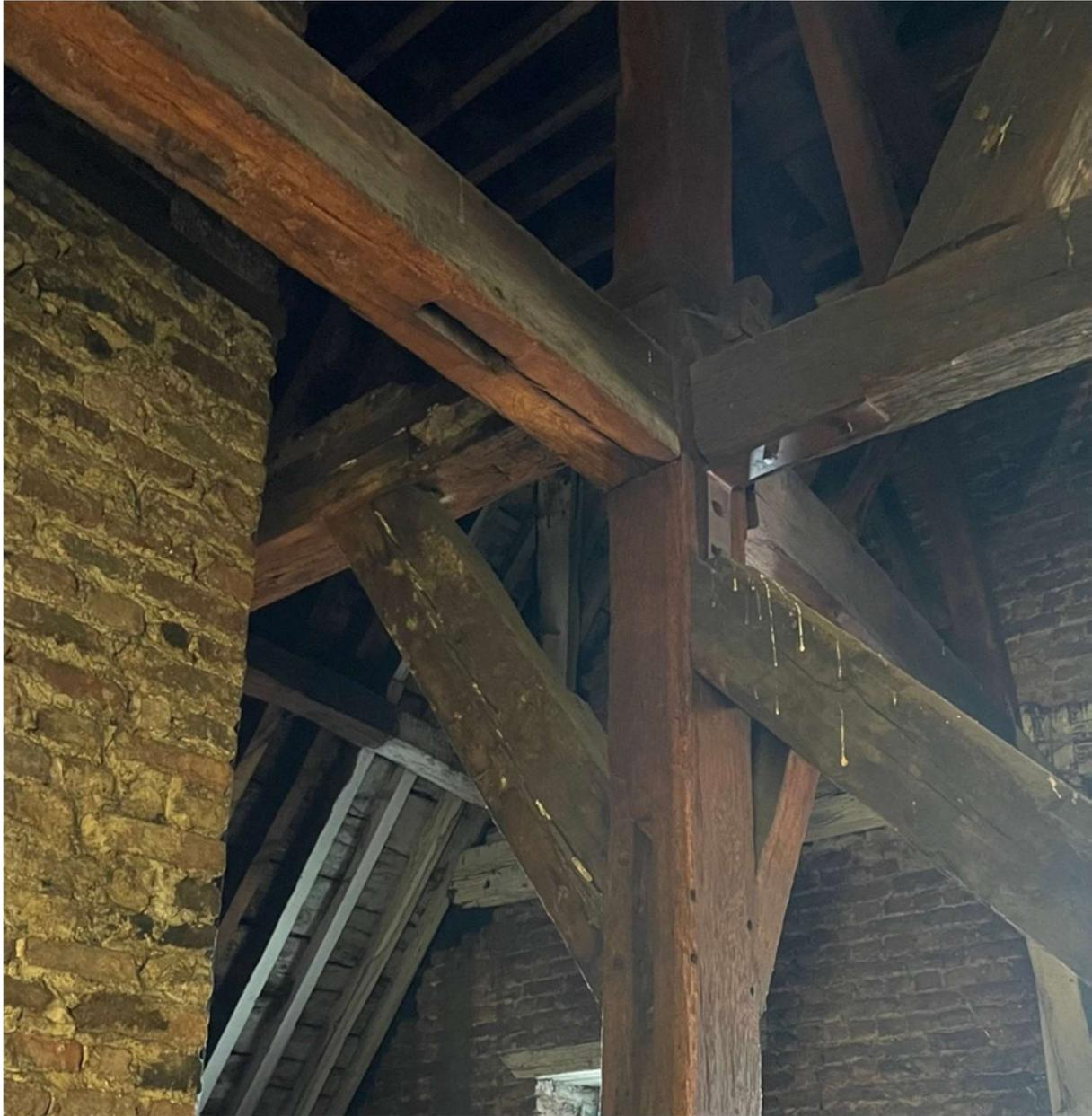
*Figure 18 : Aisselier manquant dans le nœud - Nihant, J., et al., 2022*
