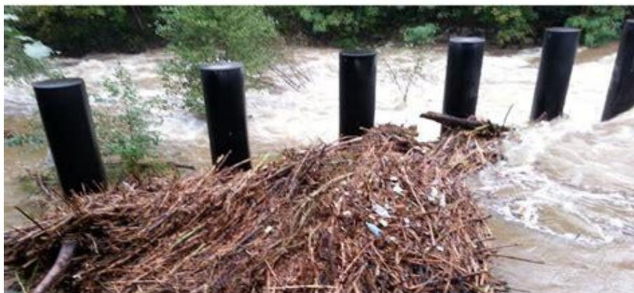
*Figure 11 : Exemple de piège à embâcles*
