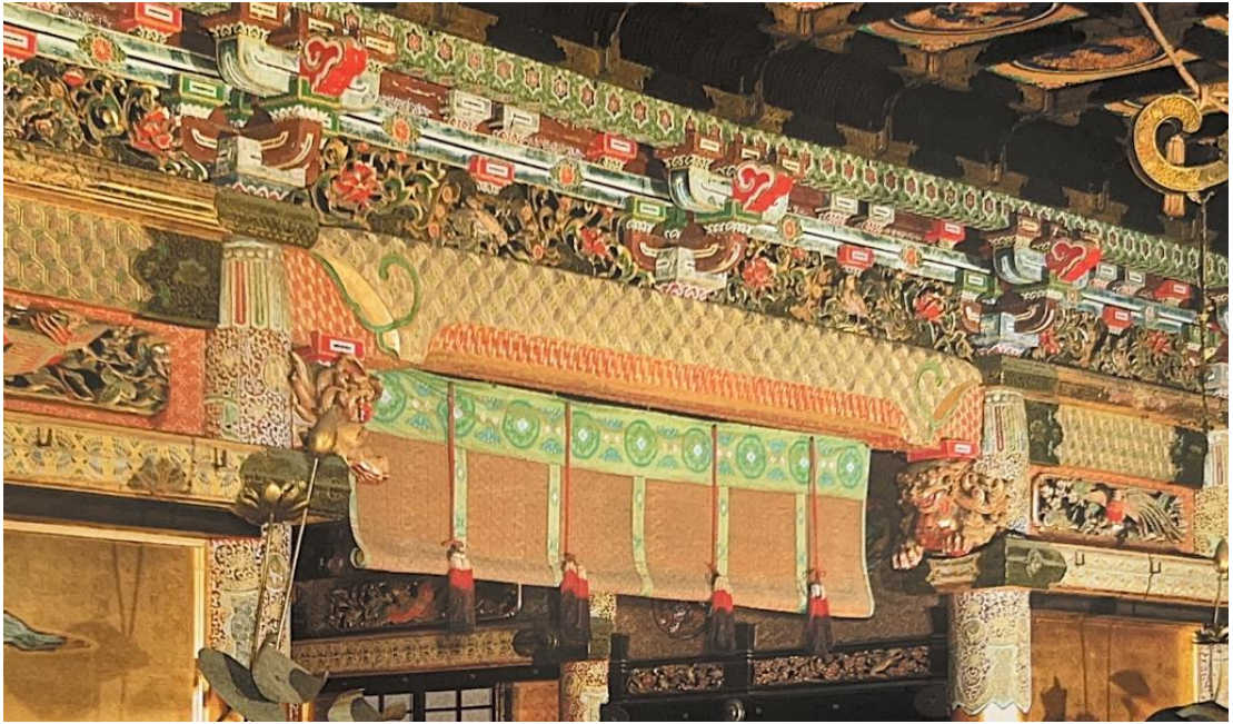
Figure 54 Consoles intérieures du hall de prière du Taiyūin ©Nikko-za Rin-noji Temple
