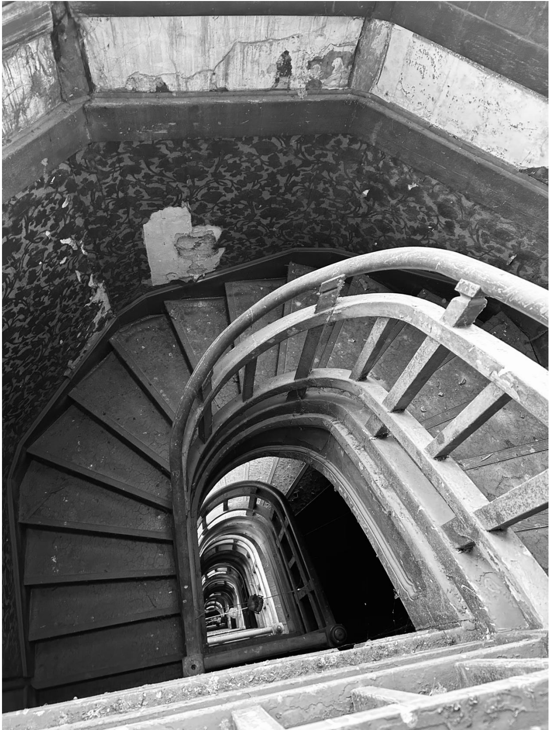
Figure 23 Escalier en colimaçon de la tour ©Büsra Jouant
