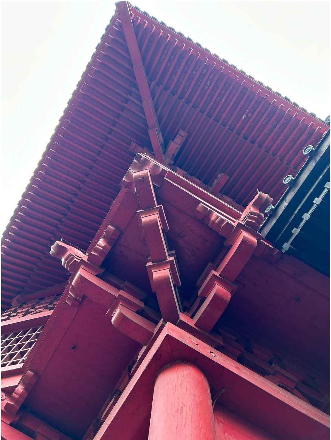
Figure 22 L'ensembles de consoles, kumimono 組物 ©Büsra Jouant
