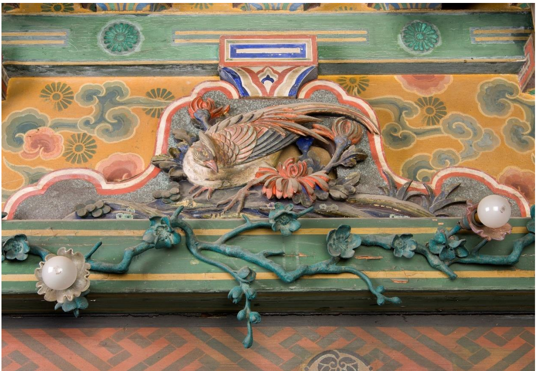
Figure 57 Montant en jambes de grenouilles, kaerumata 藁股 au R+3 de la tour ©KIK-IRPA
