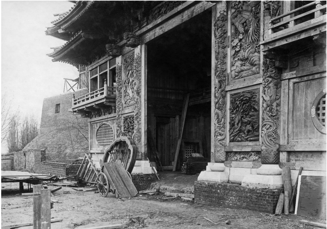
Figure 11 Remontage du pavillon d'entrée ©BALaT
