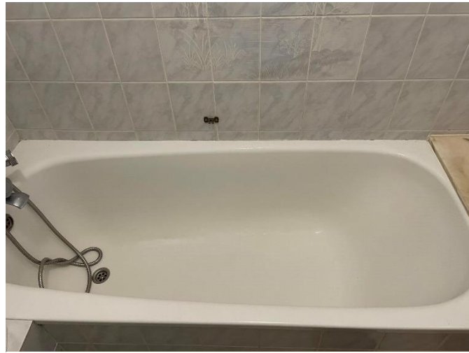
Figure 61 : Photo avant démontage de la baignoire E3
