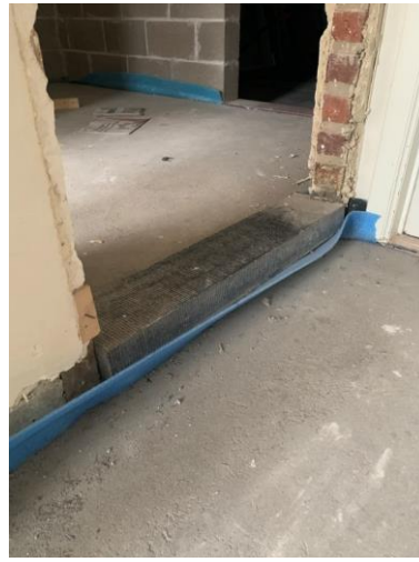
Figure 62 : Seuil en pierre réinstaller par l'entrepreneur dans le chantier de rénovation
