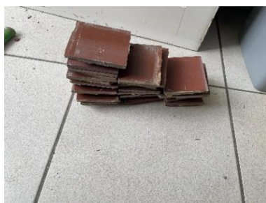
Figure 54 : Démontage des plinthes C1
