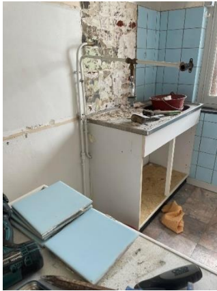
Figure 53 : Démontage du carrelage B1
