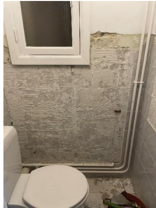
Figure 52 : Démontage du carrelage B2
