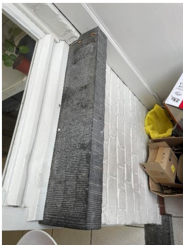
Figure 63 : Seuil en pierre avant démontage par l'entrepreneur
