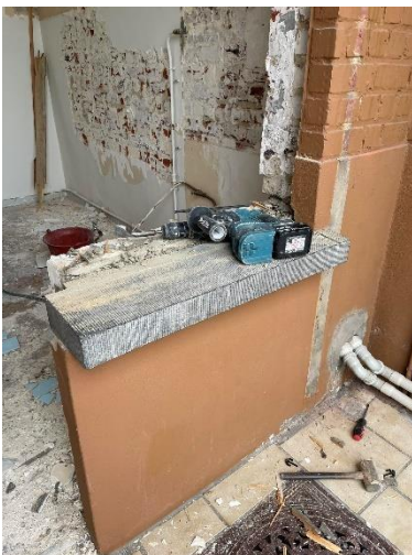
Figure 59 : Photo avant démontage du seuil de fenêtre en pierre F1
