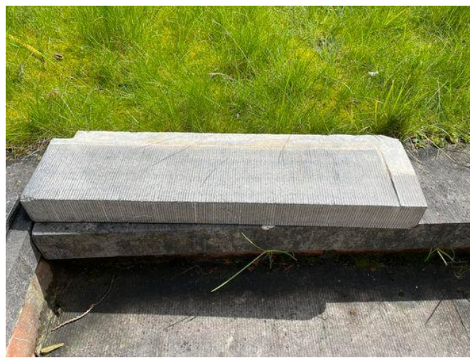
Figure 58 : Photo après démontage du seuil en pierre F1
