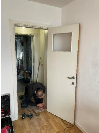
Figure 55 : Démontage des portes du rez-de-chaussée
