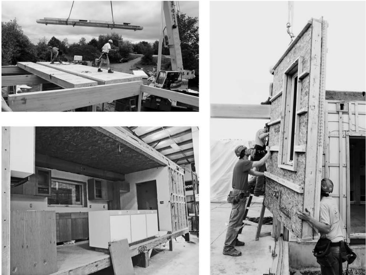
Figure 14 : « Unity House » fabriquée par Bensonwood. La conception de la maison a été faite sur base de 50 éléments de préfabriqués (Smith, 2010).
