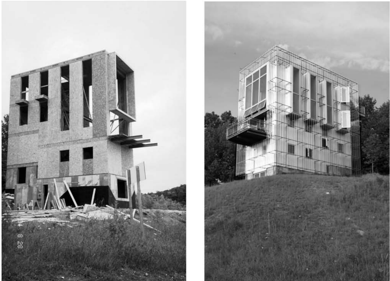
Figure 13 : Systèmes de panneaux de bois explorés par Anderson Anderson Architecture (Smith, 2010).
