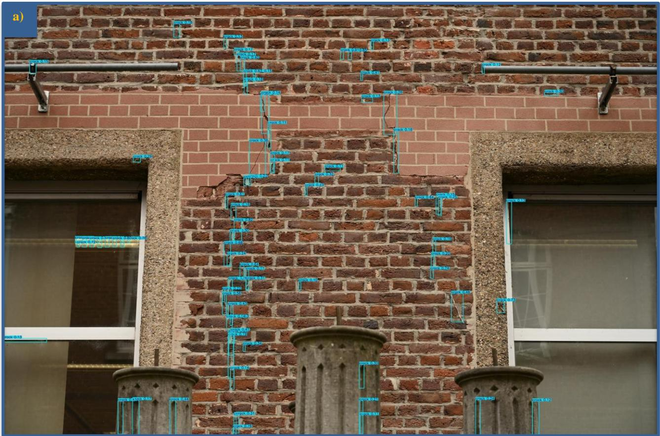
Fig. 91 – Détection sur l'échantillon A avec une image de 6048 pixels
