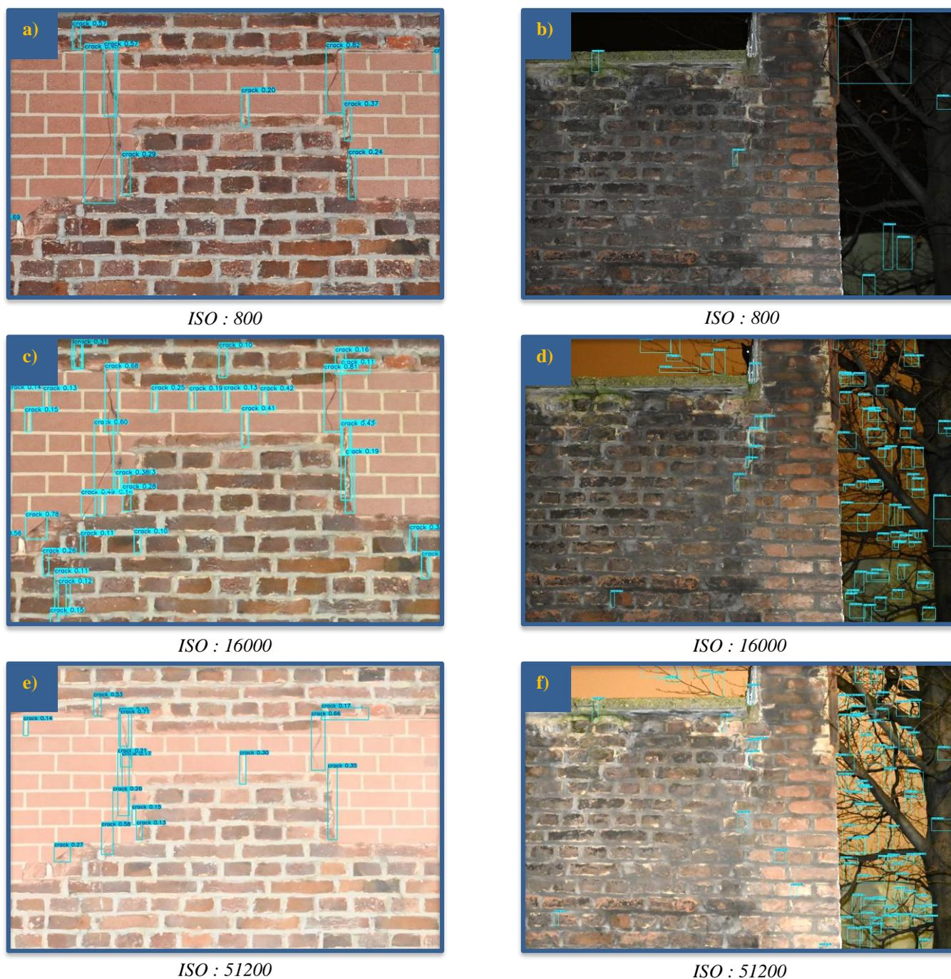
Fig. 94 – Détection sur les échantillons A et B avec différentes valeurs d'ISO
