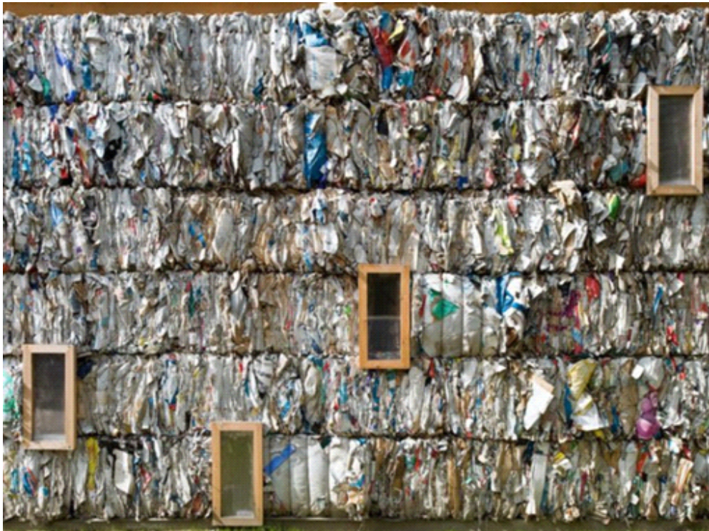
Uni par l'objet Paper House, Dratz&Dratz Bâtiment composé de 550 balles de papier recyclé compressé provenant de supermarchés de la région.
