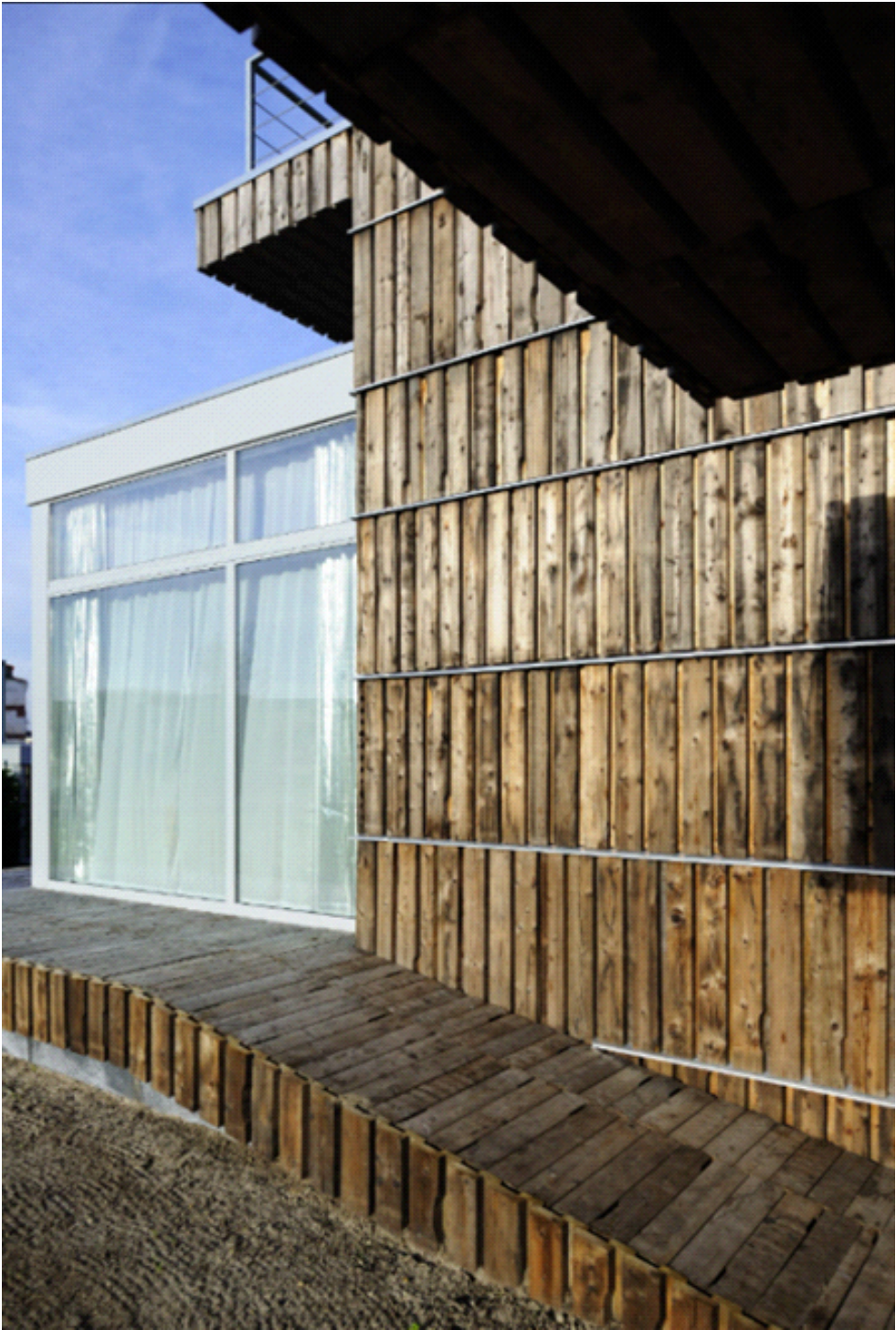
Ensemble par continuité Villa Welpeloo, Superuse Studios Bardage en bois réemployé : Lattes découpées à partir d'enrouleurs de câbles, offrant une uniformité de teinte grâce à leur origine commune.
