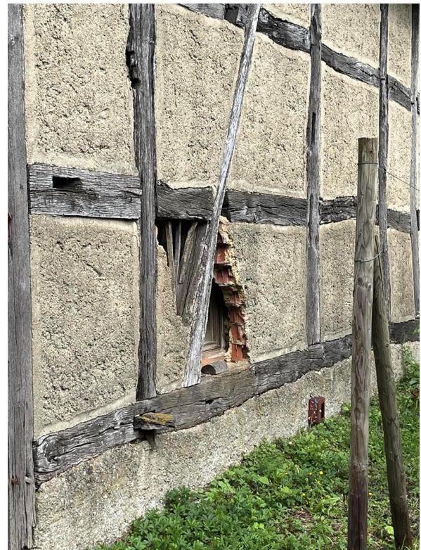
Figure 72 : Présentation de l'utilisation de briques dressées pour le torchis. Production personnelle, 2025
