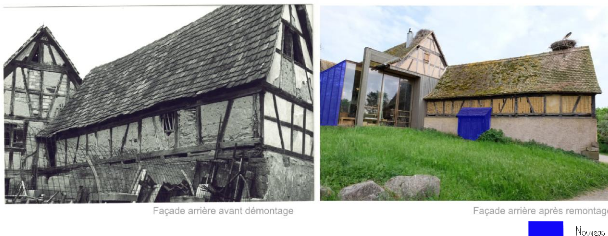
Figure 68 : Comparaison avant-après remontage de la façade arrière de l'étable d'Ittenheim. Document avant démontage provenant des archives de l'écomusée et photo après remontage personnelle, avec annotations personnelles, 2025
