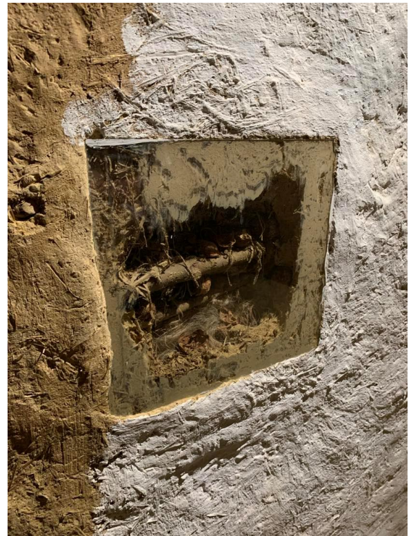
Figure 70 : Utilisation de poils d'animaux et coquilles de noix dans le torchis de la maison d'Hésingue pour augmenter les qualités thermiques. Photo personnelle, 2025
