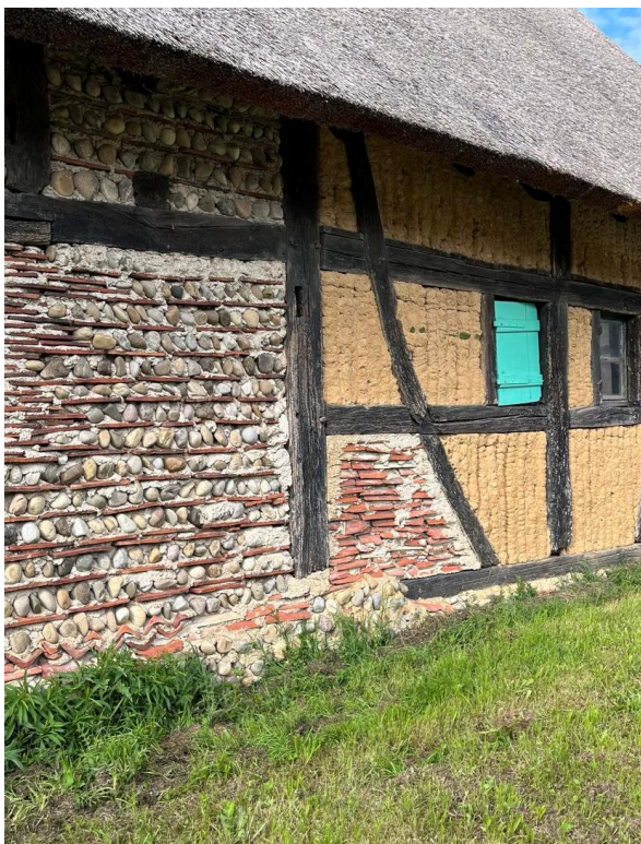
Figure 71 : Présentation de l'utilisation de petits galets montés en arête de poisson et tuiles en inter-couches pour du torchis sur la maison d'Artolsheim. Production personnelle, 2025
