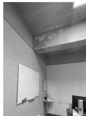
Figure 161: Infiltration d'eau dans les bureaux. 2024. ©Loix Lucie
