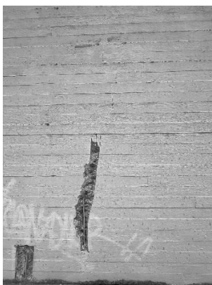
Figure 163: Faille en traitement dans la façade. ©Loix Lucie
