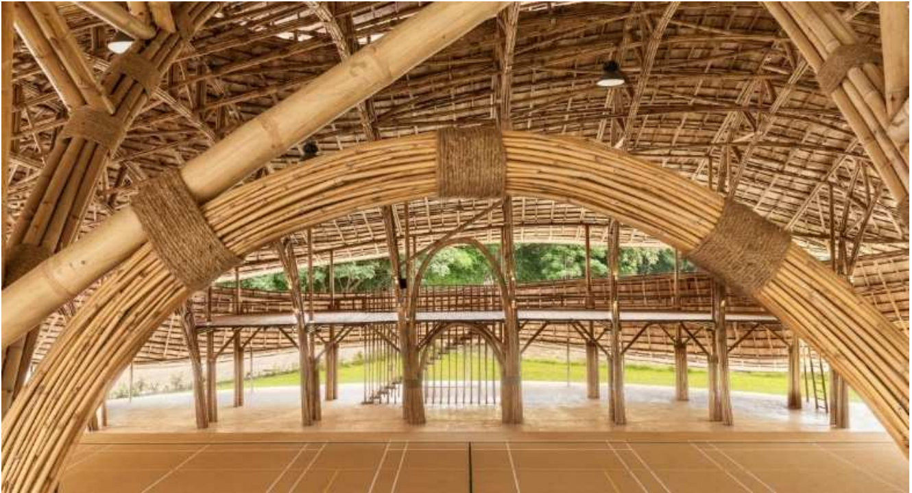
Figure 75 : Photo d'une jonction de bambous réalisée par ligature. © Alberto Cosi Source : https://www.archdaily.com/877165/bamboo-sports-hall-for-panyaden-international-school-chiangmai-life-construction
