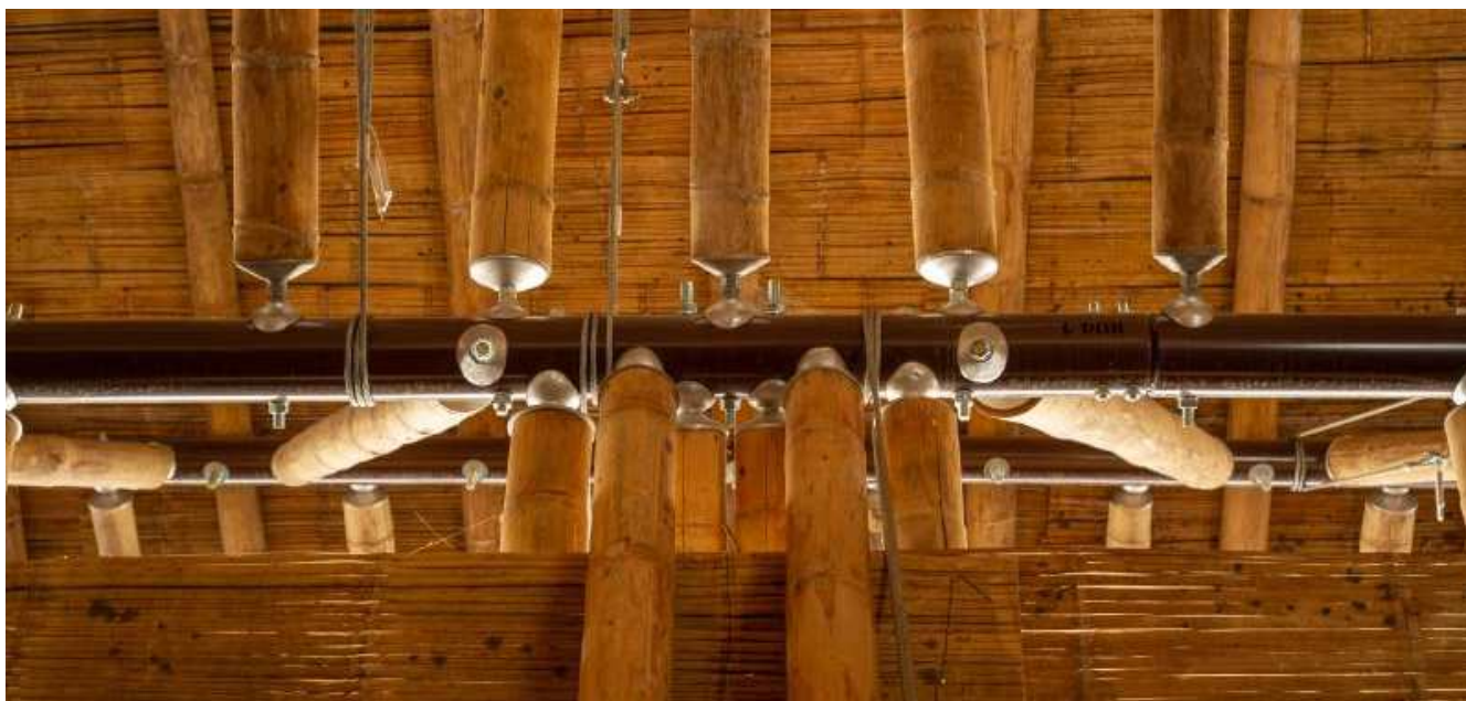
Figure 68 : Photo des jonctions métalliques entre les bambous. © Xavier de Jauréguiberry Source : https://divisare.com/projects/390925-simon-velez-architects-xavier-de-jauréguiberry-contemplation-bamboo-pavilion
