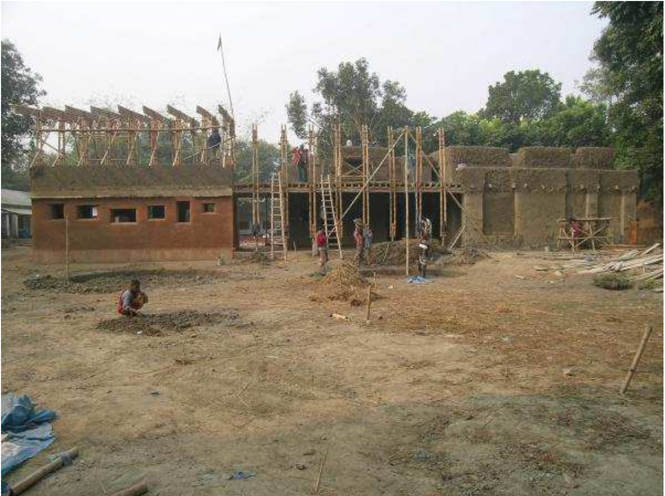
Figure 24 : Extraction de la terre pour le projet DESI d'Anna Heringer au Bangladesh Source : https://divisare.com/projects/127081-anna-heringer-b-k-s-inan-desi
