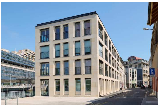
Figure 2 : Projet Coulouvrenière de L'Atelier Archiplein. @Leo Fabrizio Source : https://archello.com/fr/news/atelier-archiplein-realise-un-immeuble-de-logements-sociaux-en-pierre-massive-a-geneve
