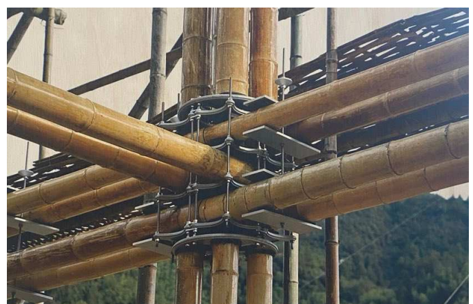
Figure 49 : Photo d'une jonction mécanique de bambous du projet NorthEast Bamboo Pavilion de atArchitecture. ©studio cardenas conscious Design
