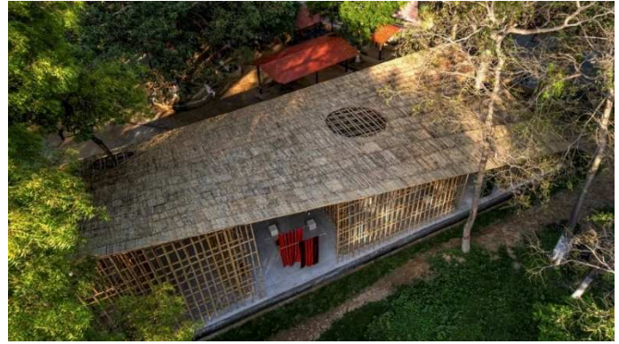
Figure 45 : Vue du toit du Northeast Bamboo Pavilion. © Suryan & Dang.
