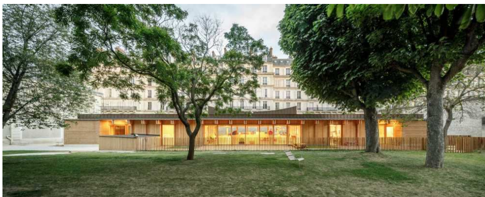
Figure 102 : Photo de l'ensemble de la crèche. Source : Atelier Régis Roudil. (2025, 23 février). Dossier de presse – Crèche 24 berceaux au Palais de l'Alma. Document transmis
