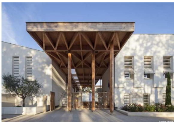
Figure 140 : Groupe scolaire à Opio de Teissier Portal. © Milène Servelle Source : https://teissierportal.com/projets/groupe-scolaire-2/
