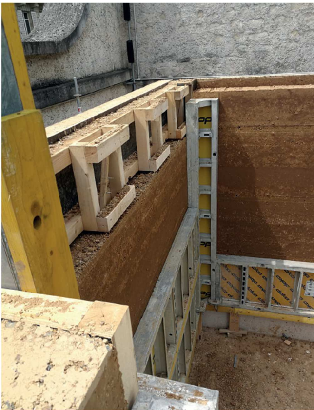
Figure 105 : Dispositif de coffrage pour la mise en œuvre du pisé. Source : Atelier Régis Roudil. (2025, 23 février). Dossier de presse – Crèche 24 berceaux au Palais de l'Alma. Document transmis personnellement.
