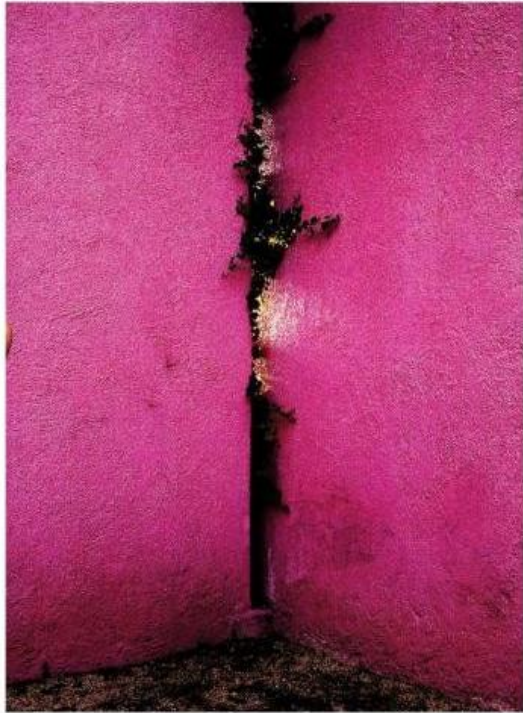
Figure 47 Casa Estudio, faille située à la jointure des murs
