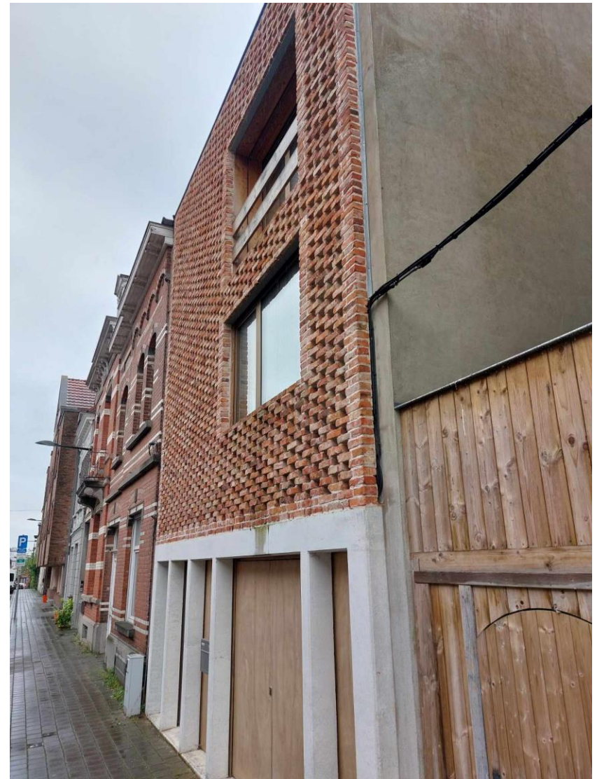
Ill. 07.03, Typologies de pose de briques de parement, 106-108 Rue de la Vignette, 1160 Auderghem, photographie d'Antoine Willame, 2025
