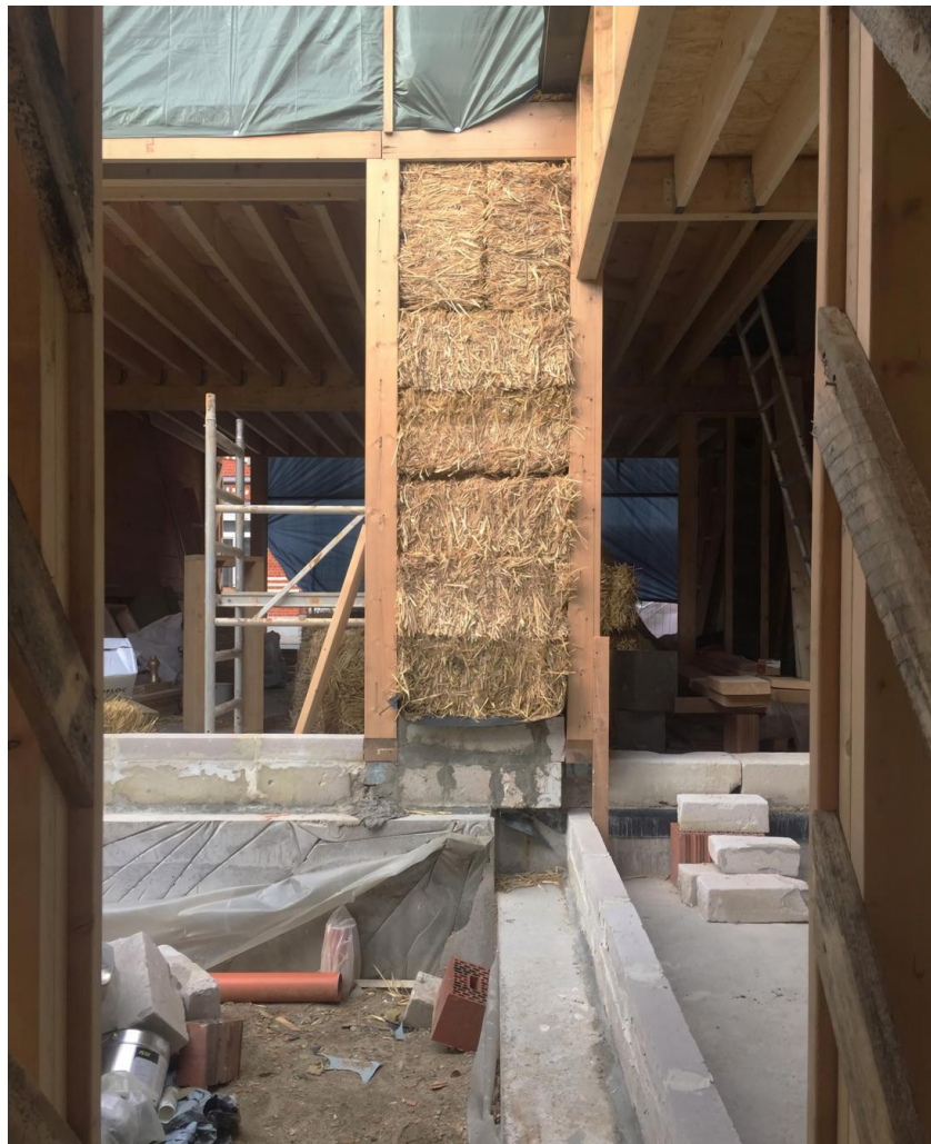
Ill. 07.06, Ossature en bois de type poteau/poutre remplie de bottes de paille, photographie de Karbon' Architecture, s.d.
