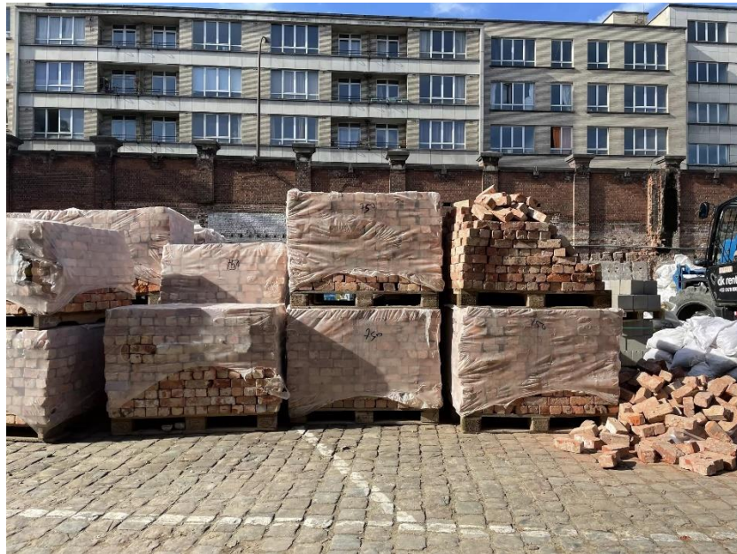
Ill. 07.18, Briques stockées sur site attendant d'être réutilisées après démontage des bâtiments voisins, photographie de BC Architects, s.d.
