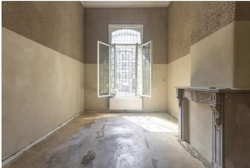
Ill. 07.19, Enduit d'argile acoustique placé sur les murs - les 2 mètres inférieurs sont finis avec un enduit de base en argile et au-dessus de 2 mètres avec un enduit d'argile acoustique, photographie de Ponceuse Lambrix, s.d.
