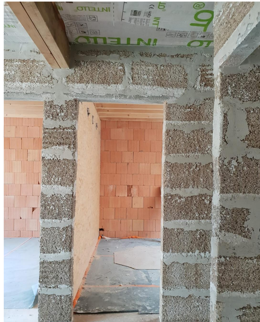
Ill. 07.07, Cloisons et contre cloisons sont réalisés en blocs de béton de chanvre-chaux, photographie de Karbon' Architecture, s.d.
