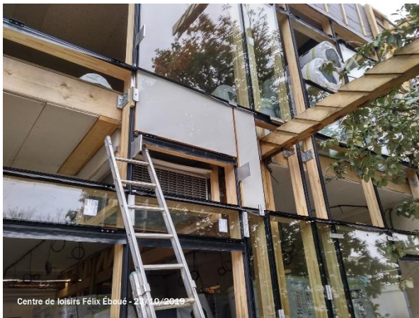
Illustration 21 : Les échangeurs durant le chantier - Mairie de Rosny-sous-Bois
