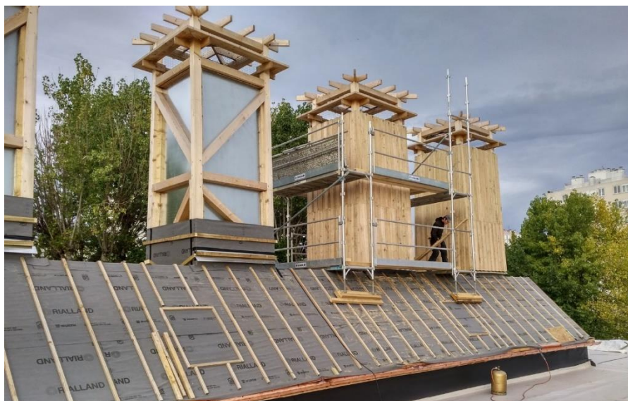
Illustration 22 : Les tours à vent - Mairie de Rosny-sous-Bois
