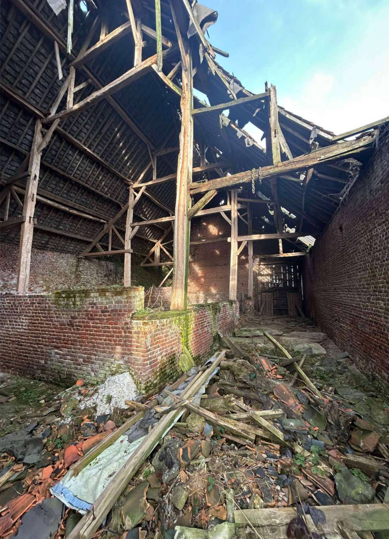
Figure 56 : Effondrement d'une partie de la toiture de la grange
