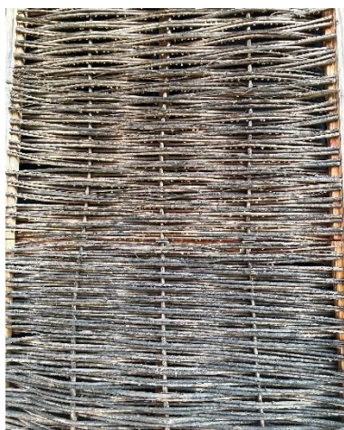
Figure 10. Photo : Bardage de l'Infrastructure Nature de Braives. Crédit : Rans Julie (2025)
