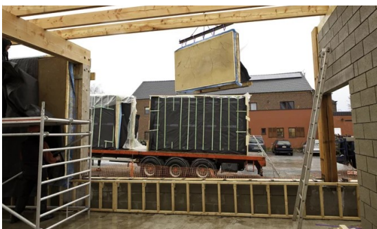
Figure 81. Photo des modules préfabriqués de Paille-Tech. Crédit : Paille-Tech
