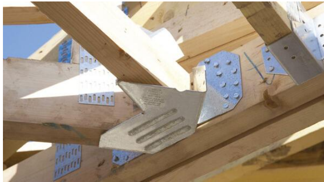
Figure 21 : Image d'une jonction de pièces dans une ossature bois avec des renforts de maintien [73]
