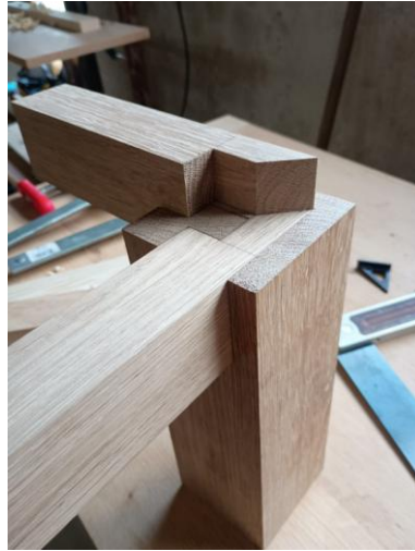
Figure 92 : Emboîtement vertical du joint
