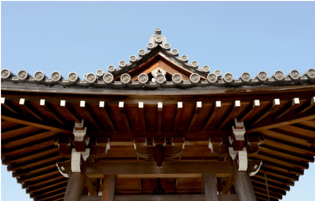
Figure 17 : Disposition des chevrons sous l'avancée de la toiture [71]
