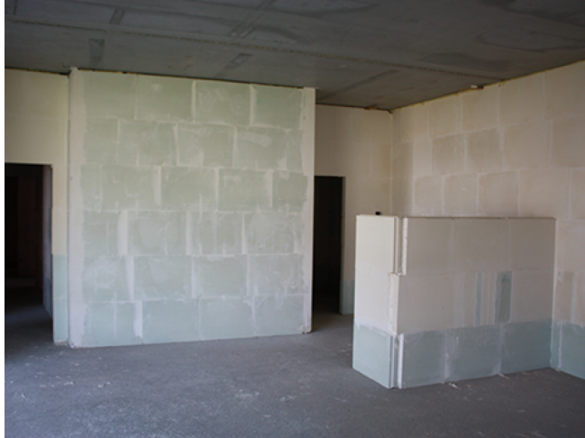
FIGURE 1.11 – Cloison en blocs de plâtre (ABLG, 2025)
