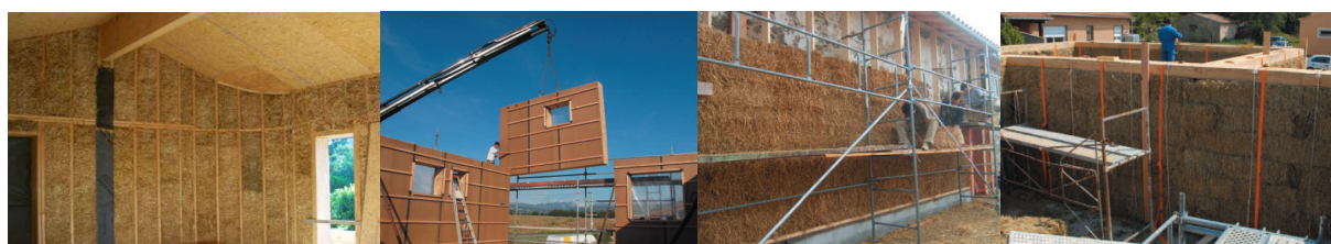
(a) Le remplissage (b) La préfabrication (c) Isolation (d) La paille structurelle
