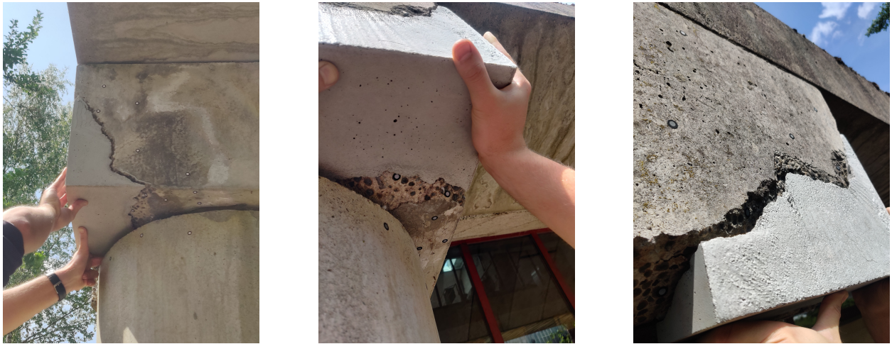
FIGURE 111 – Élément de restauration du chapiteau placé sur l'élément dégradé
