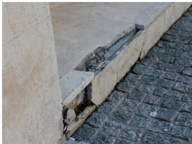
FIGURE 11 – Désagrégation du béton (Jesus et al., 2023)
