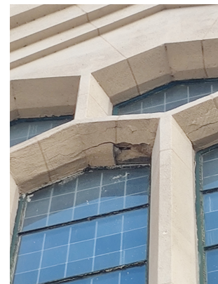
FIGURE 13 – Béton carbonaté - église St Vincent, Liège
