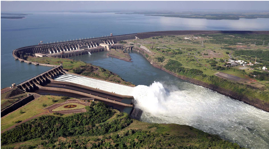
FIGURE 1.1 – Barrage d'Itaipu. Évacuateur de crue en fonctionnement du barrage d'Itaipu (Brésil/Paraguay) (ITAIPU BINACIONAL, 2025)
