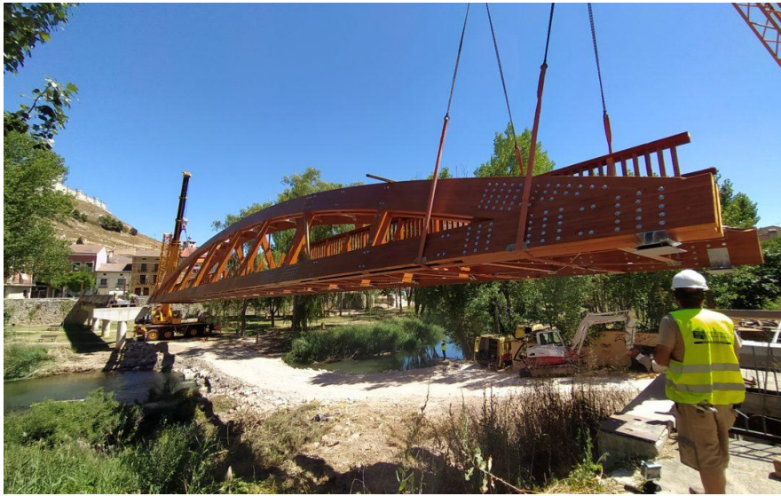
Figure 16: Puente Peñafiel (Valladolid) - (Montaje del Puente de Peñafiel, 2022)
