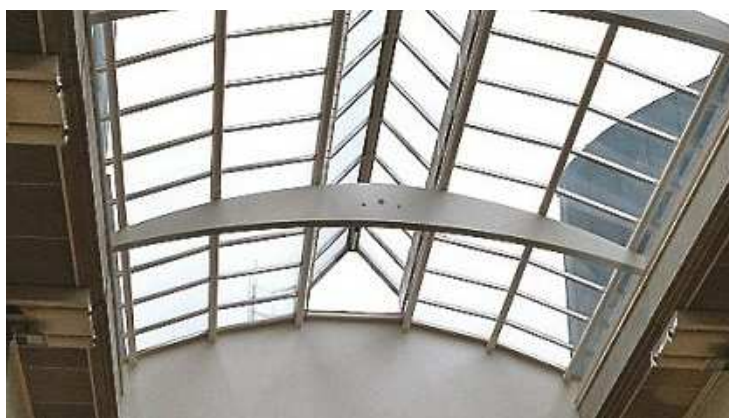
FIGURE 5-4: PHOTO DE LA VERRIÈRE DE L'ATRIUM (VUE DE L'INTERIEUR)
